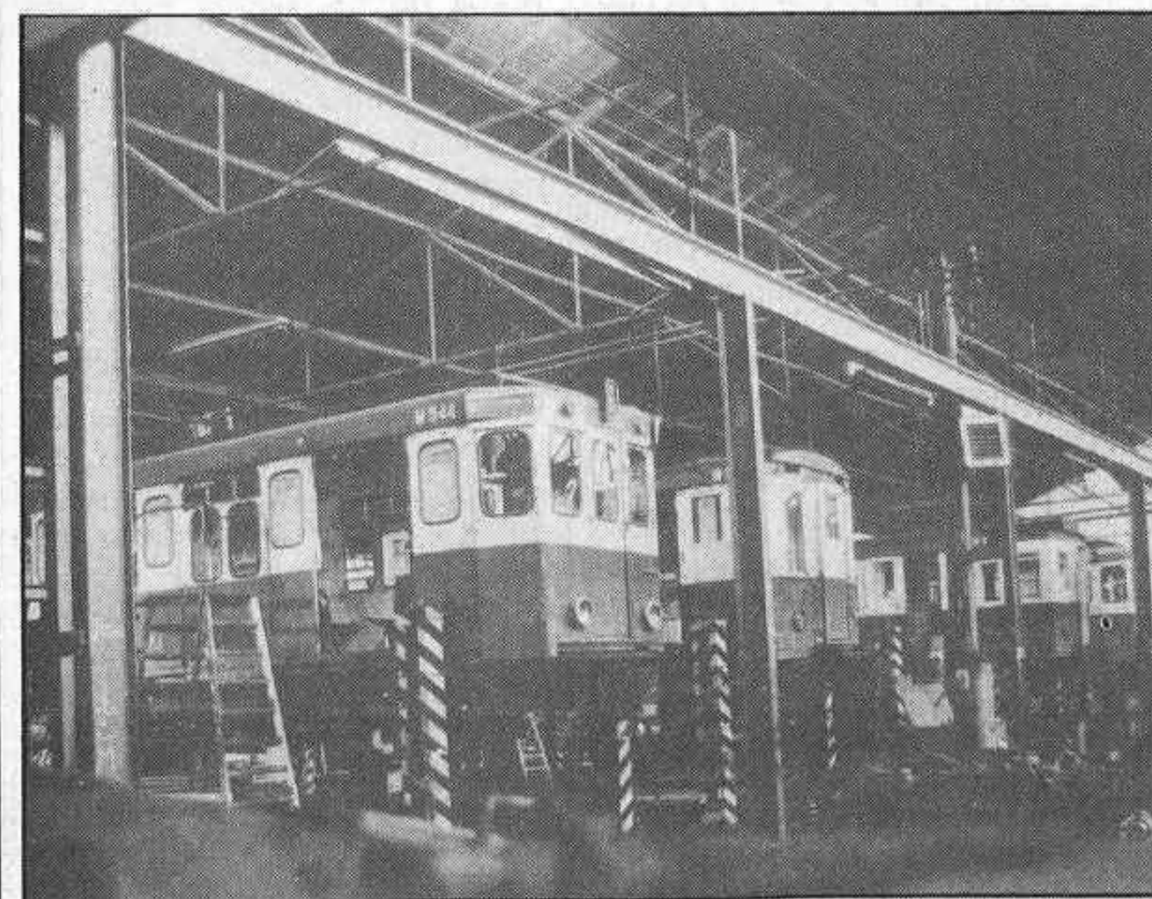
Instalación en los metros de las líneas 1, 2, 3, 4 y 10 del Sistema de Protección del Tren (ATP).
