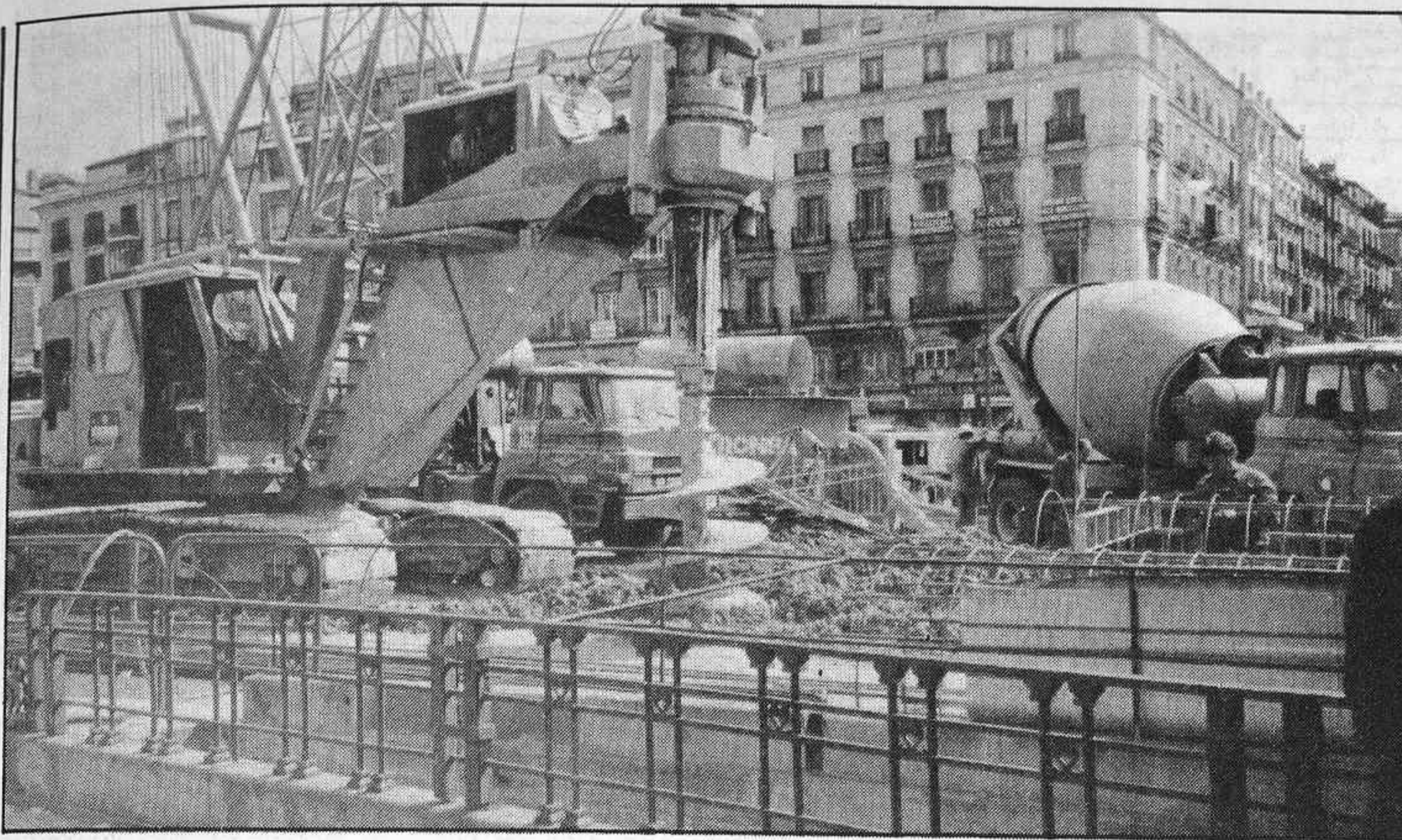
La terminación de la estación de Sol y las grandes máquinas que para ello se precisan dificultan aún más la circulación en la madrileña Puerta del Sol.
