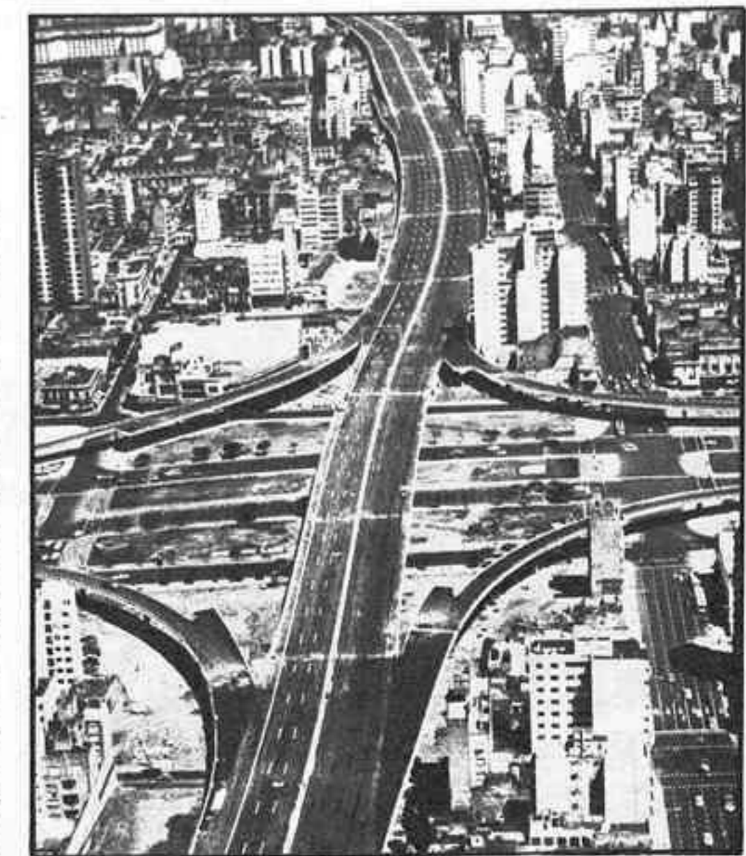
Autopista A-1, asesoramiento técnico a la construcción por nuestra ingeniería
