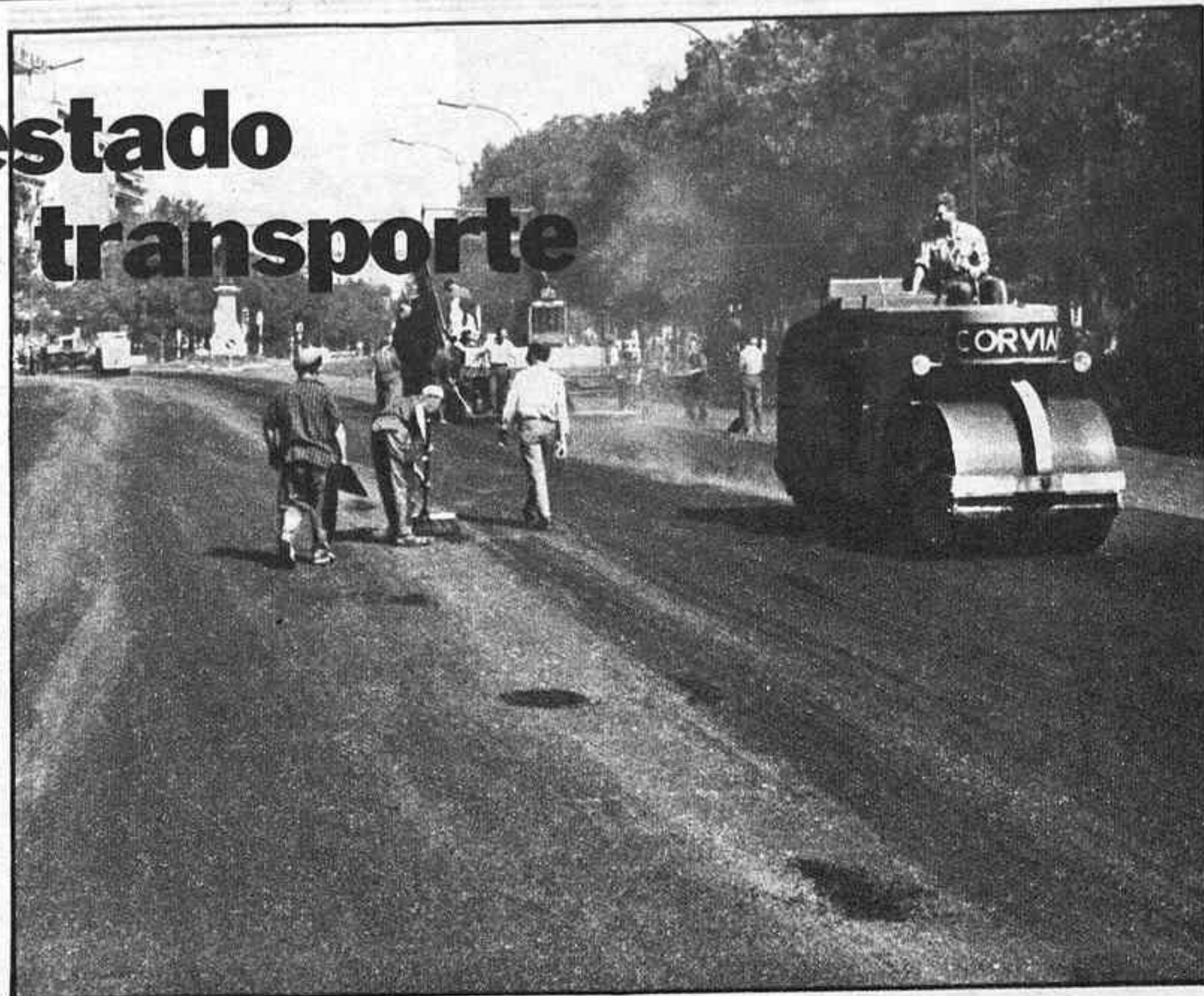
Pavimentación del paseo de la Castellana
