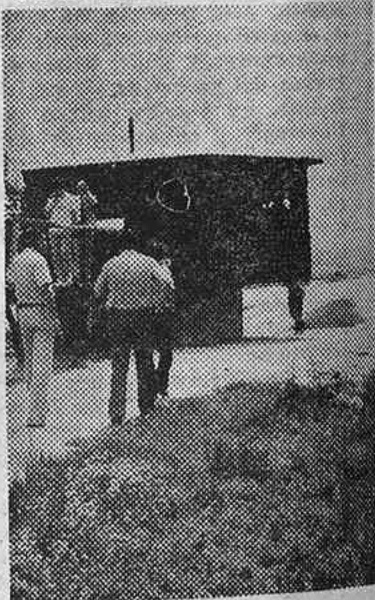
Uno de los puntos de observación a modo de casamata provista de troneras de los que el Canal de Isabel II proyectó para el embalse. (Torremocha.)
