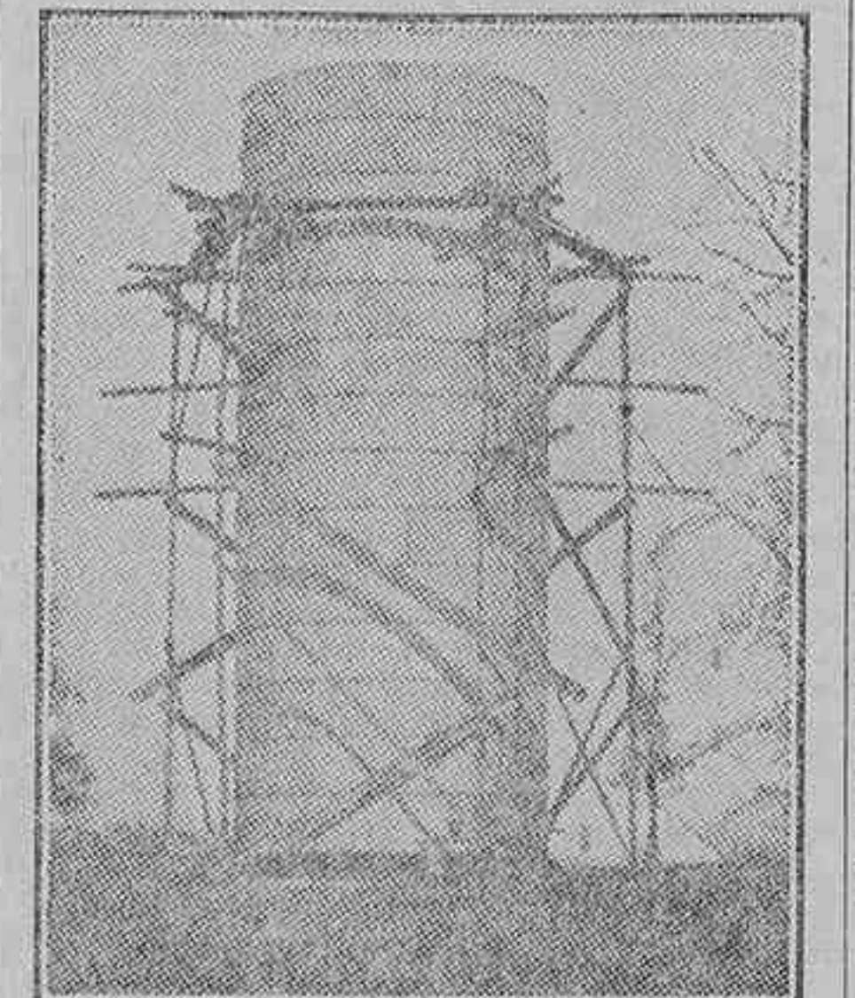
Silo metálico incombustible en construcción
