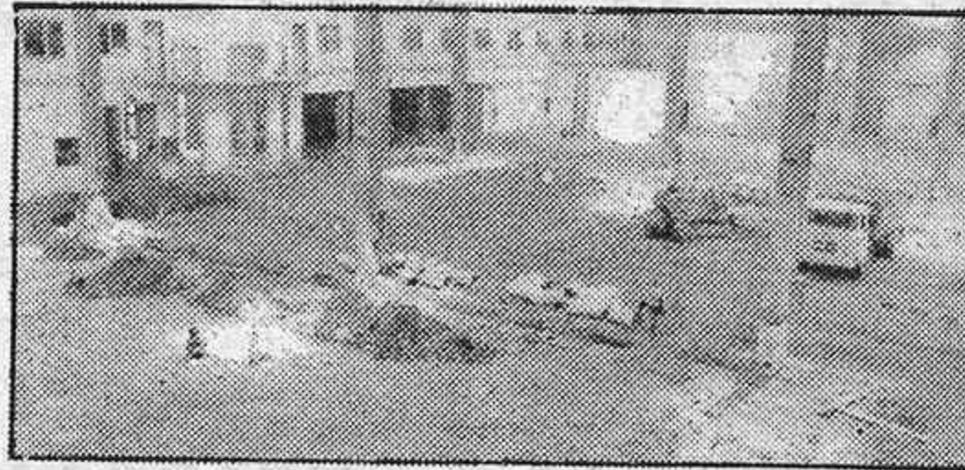
Obras en el interior de uno de los principales palacios
