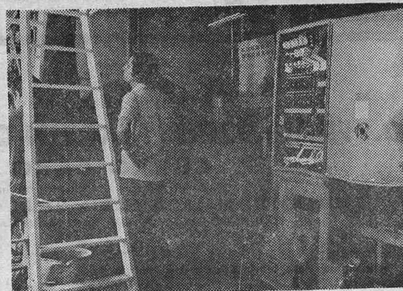
Operarios de Rotopress intentan reparar a toda prisa la estereotipia, gravemente afectada por la explosión. (Torremocha.)
