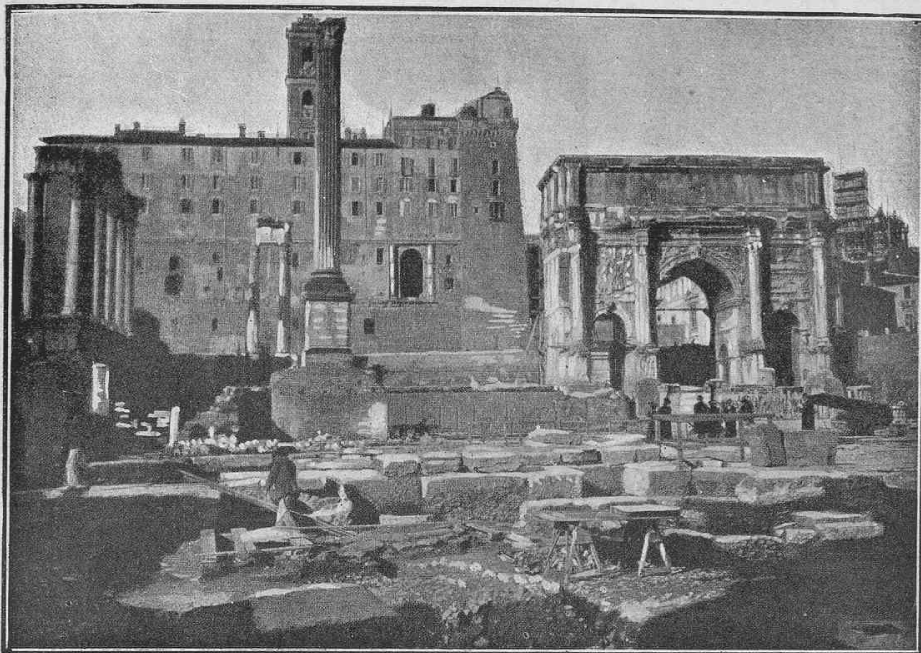
Estado actual de las obras
