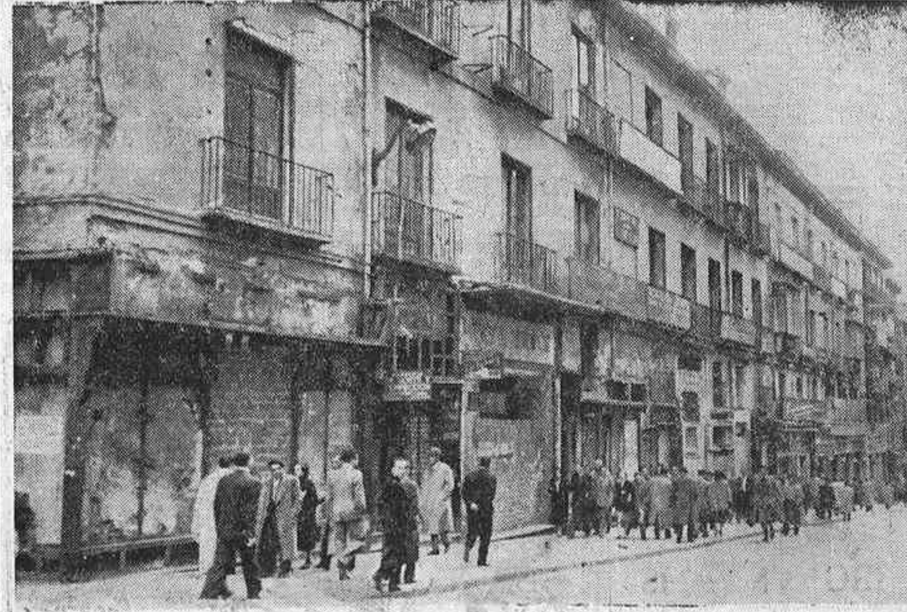
En la fachada de la casa número 24 de la calle de la Montería, en obras de demolición, sólo queda la huella de la lápida dedicada al marqués de Urquijo...
