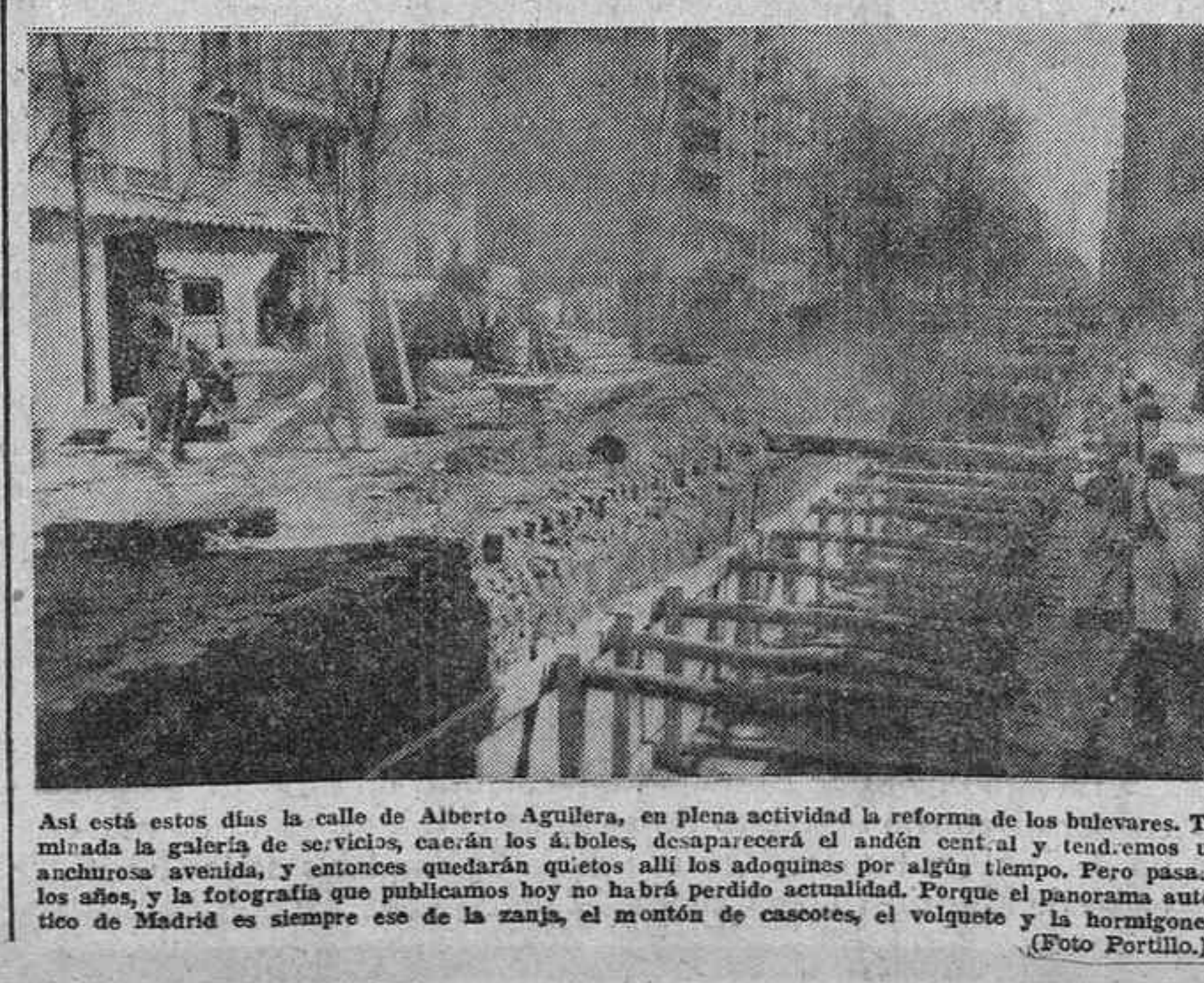
Así está estos días la calle de Alberto Aguilera, en plena actividad la reforma de los bulevares. Terminada la galería de servicios, caerán los árboles, desaparecerá el andén central y tendemos una anchurosa avenida, y entonces quedarán quietos al no los adoqueos por algún tiempo. Pero pasarán los años, y la fotografía que publicamos hoy no habrá perdido actualidad. Porque el panorama auténtico de Madrid es siempre ese de la zanja, el montón de cascos, el volquete y la hormigonera. (Foto Fortillo.)
