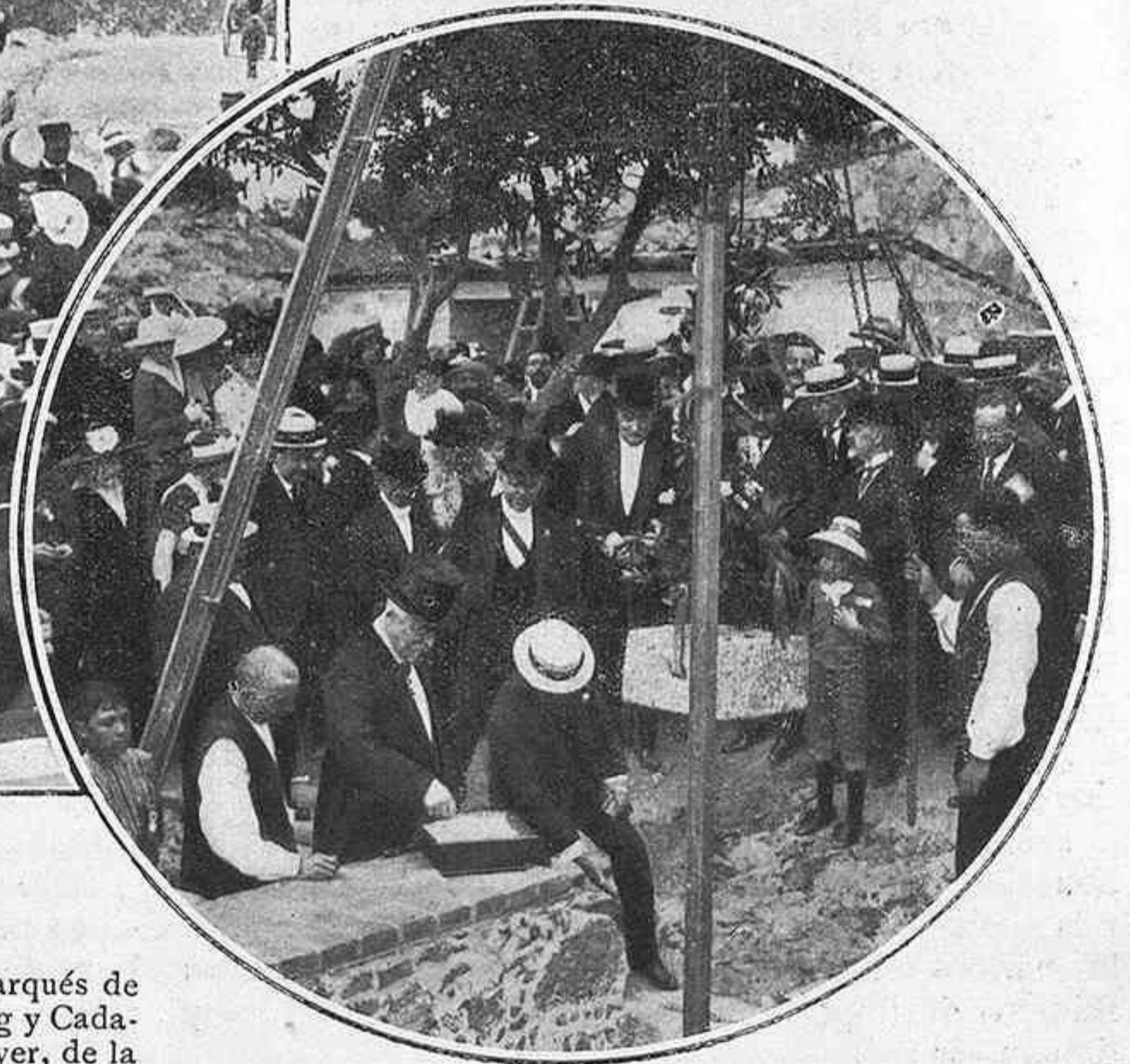
El Sr. Poincaré colocando la primera piedra del nuevo hospital
