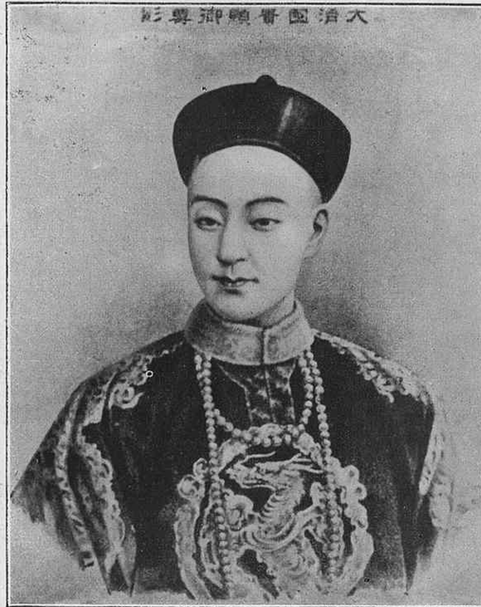
Kuang-Su, emperador de la China recientemente fallecido (De fotografía de Nouvelle-Photo.)
