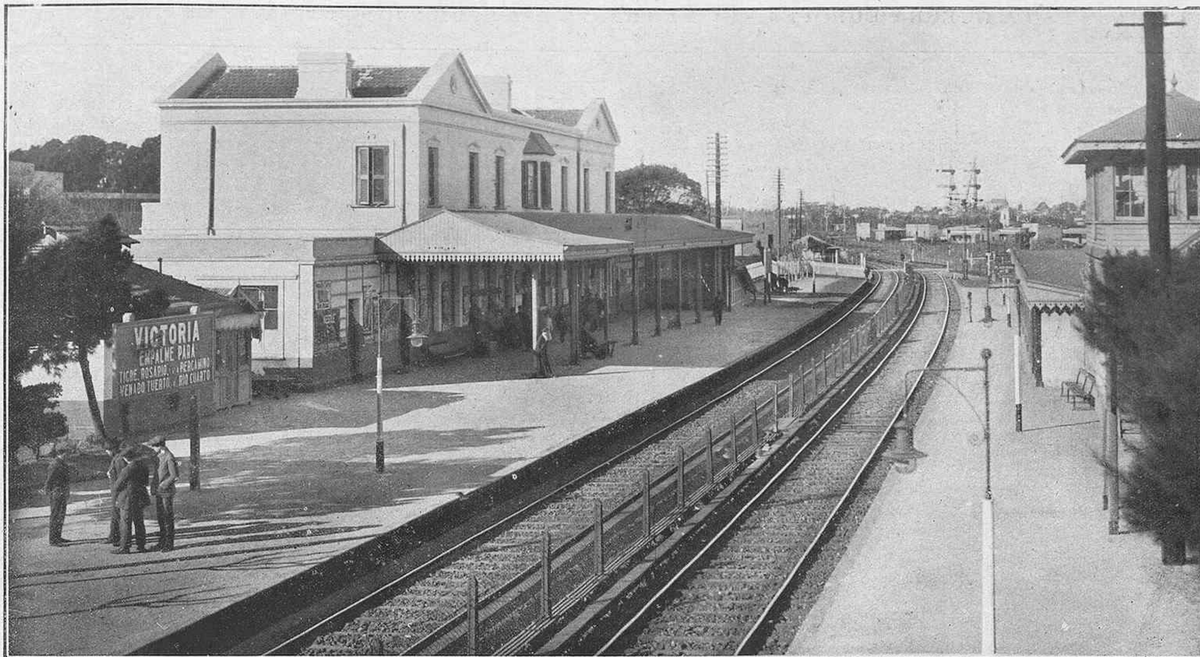
La estación Victoria, en donde se ve, entre las vías, el tercer riel del que toman la corriente los patines de los coches
