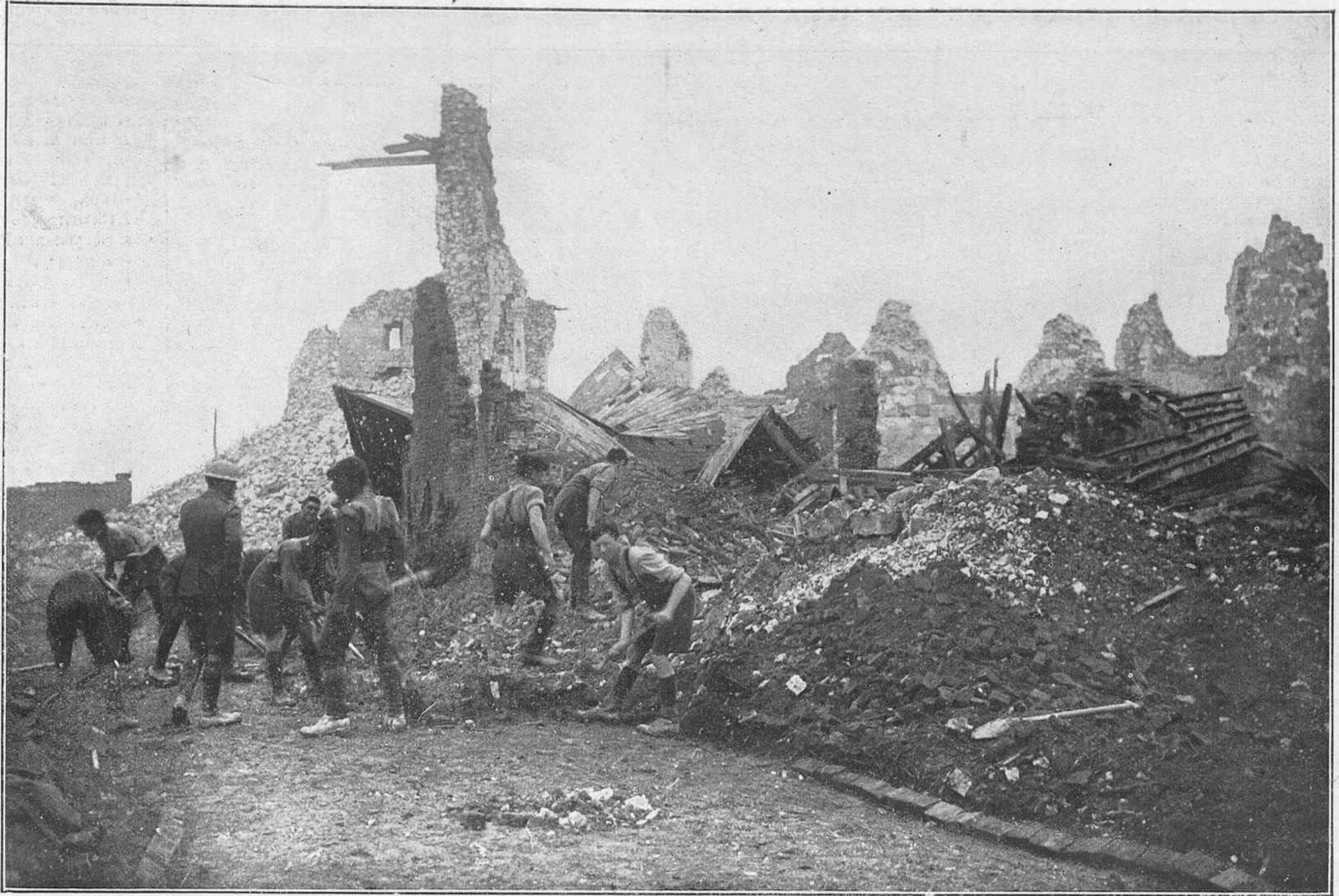
Soldados ingleses construyendo un camino al través del pueblo conquistado de Contalmaison para facilitar un nuevo avance
