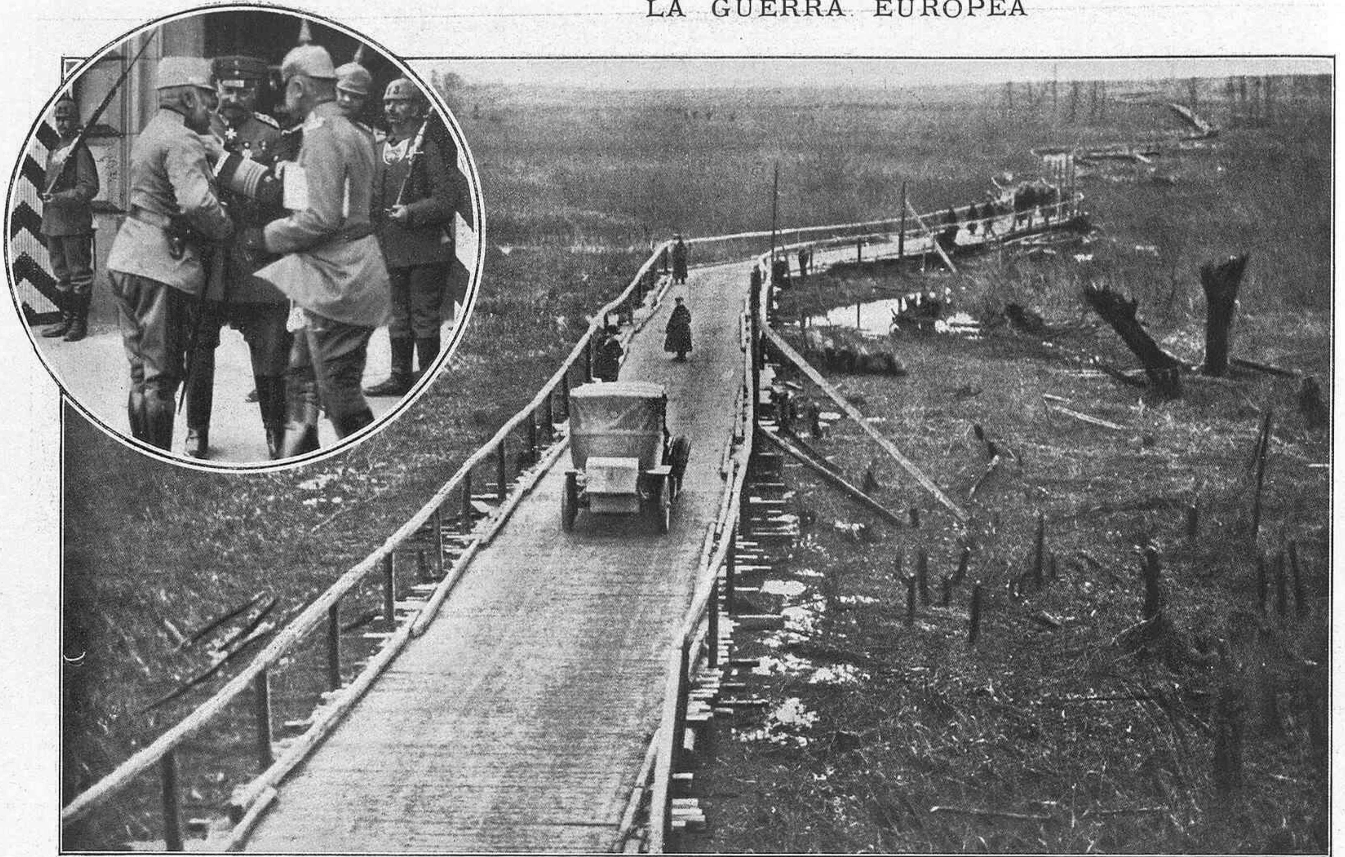
Puente de madera de varios kilómetros de longitud construido en una región pantanosa de Rusia por los ingenieros alemanes en 36 horas. — En el círculo, el emperador de Alemania imponiendo la cruz de la orden «por el mérito» al archiduque Federico de Austria. (De fotografías de Hofer.)
