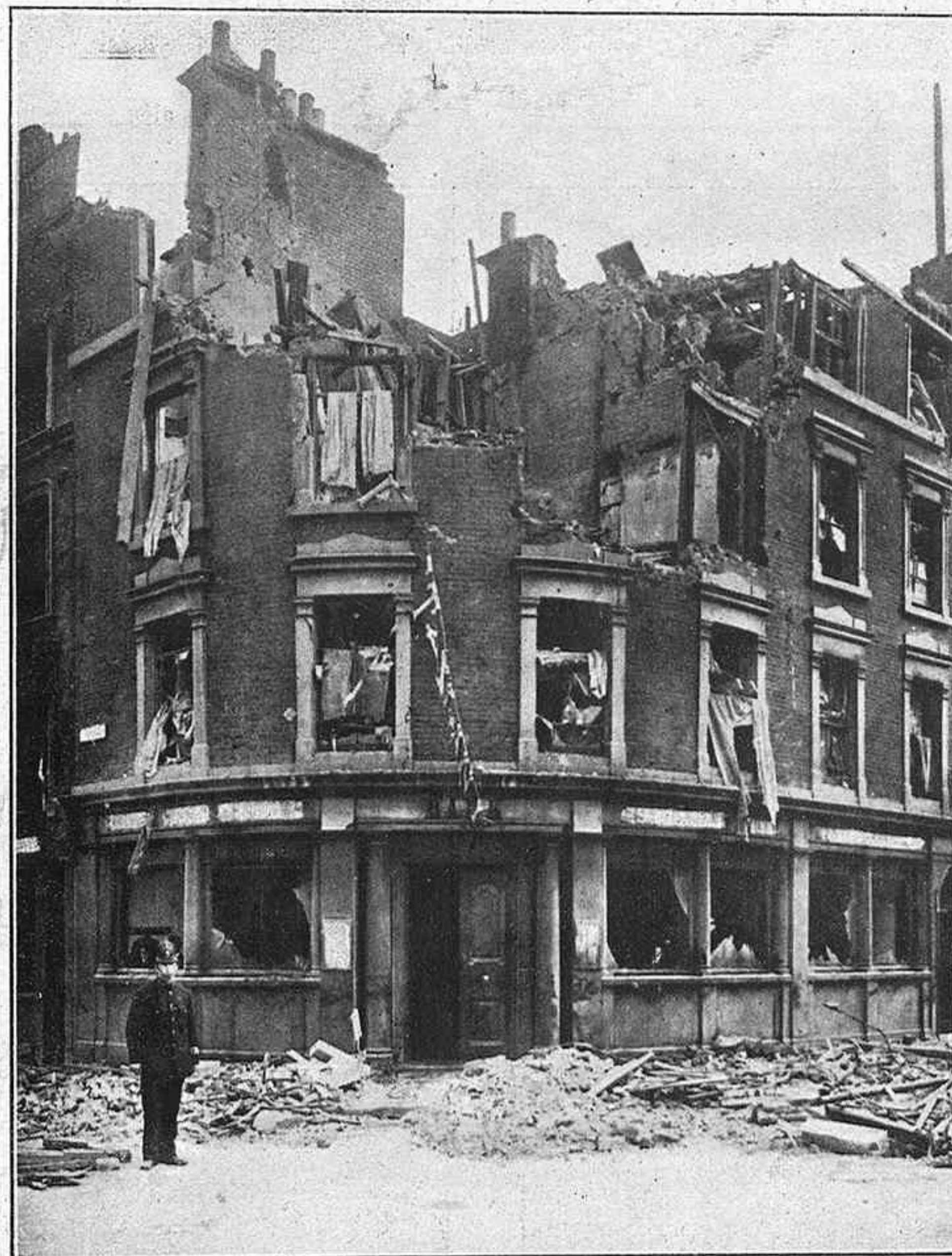
Londres. - Destrucción causada en una casa por una de las bombas arrojadas por los zeppelines en el último raid efectuado sobre la capital inglesa. (De fotografía de Walshams, Ltd., remitida por Carlos Trampus.)
