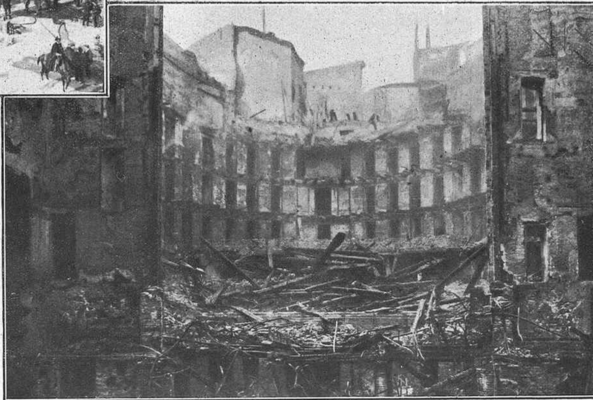
Vista del interior del teatro tomada desde el fondo del escenario después de sofocado el fuego (De fotografías de nuestro reportero A. Merletti.)
