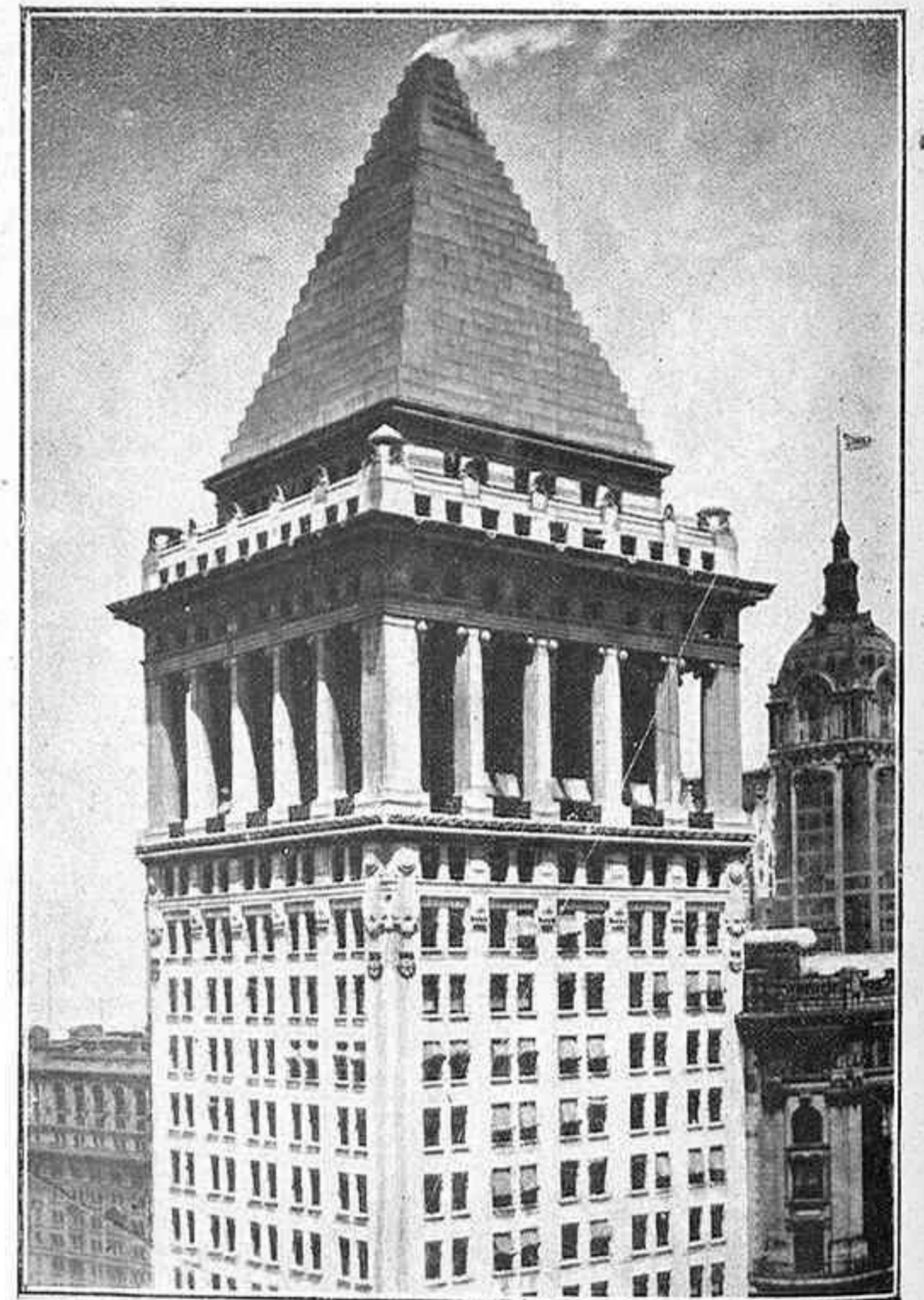
Cámara acorazada para guardar caudales instalada por la casa de banca neoyorkina «The Bankers Trust Co» en la cúpula de un rascacielos de 41 pisos. (Fot. remitida por C. Trampus.)
