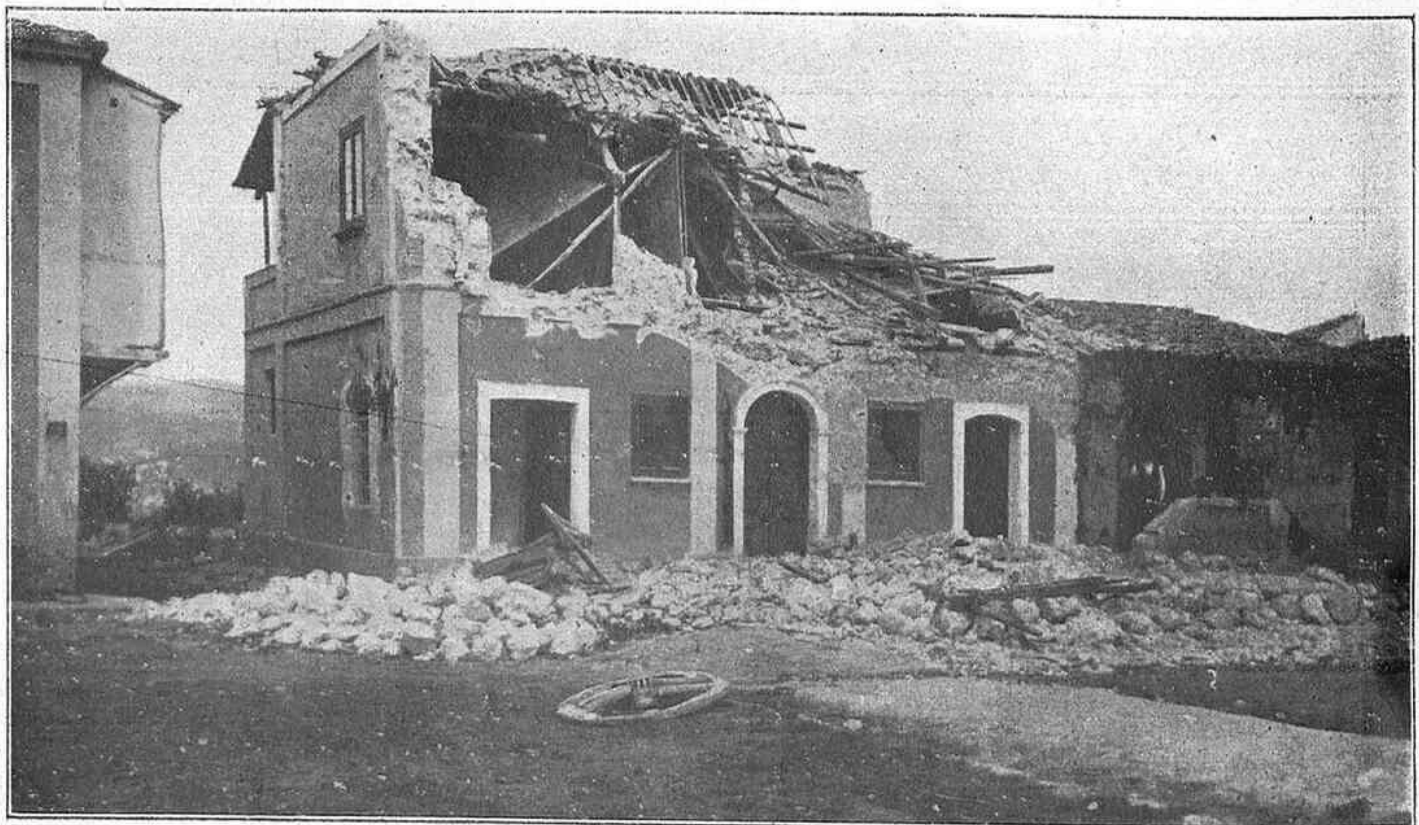
Regio.—El edificio del Banco después del terremoto. (De fotografía de World's Graphic Press. París.)
