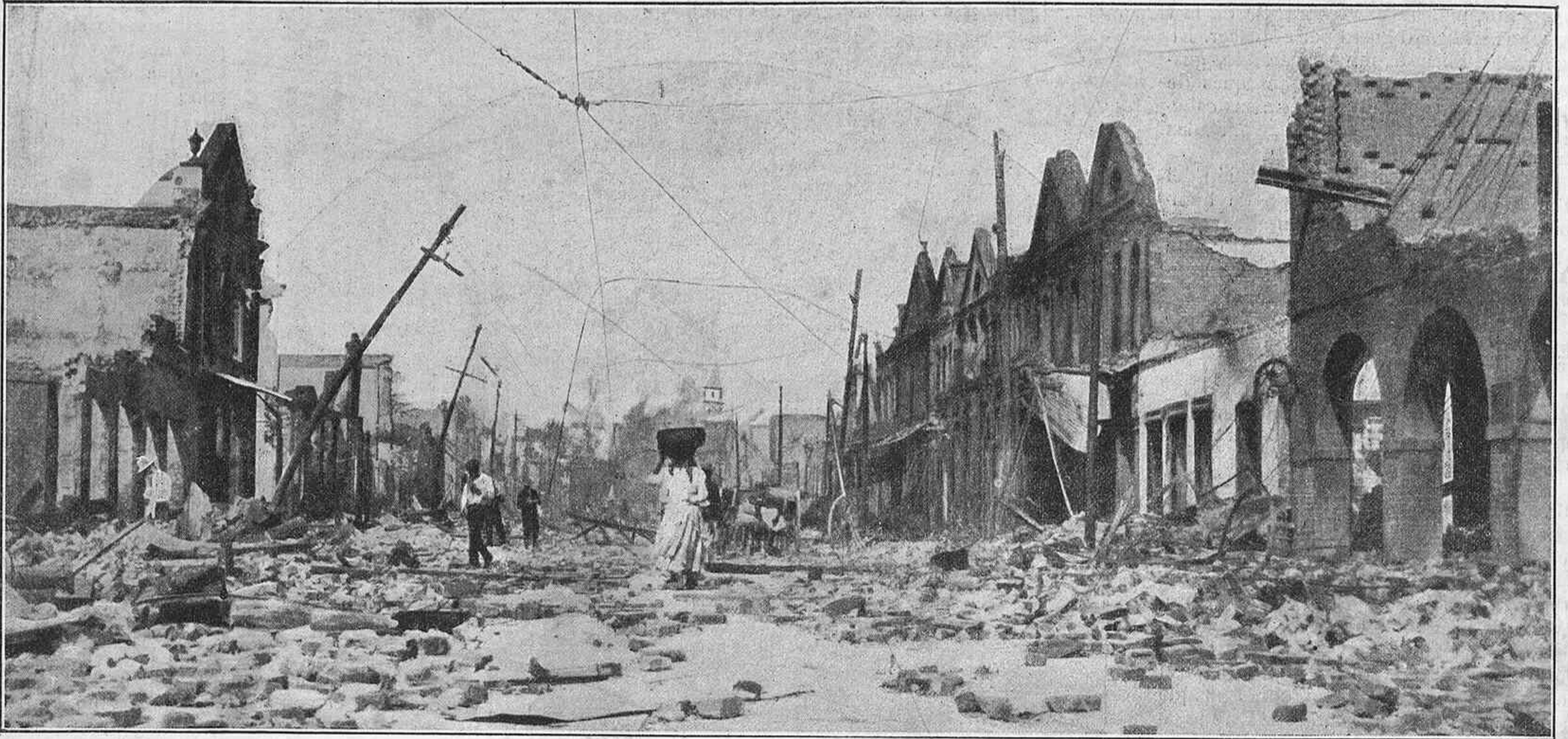
VISTA DE LA KING STREET. A LA DERECHA, LOS ARCOS DE LA COMPAÑÍA LYONS LTD. Y LAS PAREDES DE LA DROGUERÍA CROSWELL Y DE LA JOYERÍA MEIKES. A LA IZQUIERDA, LAS RUINAS DE LA ESTACIÓN DE LA COMPAÑÍA ELÉCTRICA WEST INDIA, DEL ALMACÉN DE MUEBLES FISHER Y DE LA FERRETERÍA MIDDLETON.
