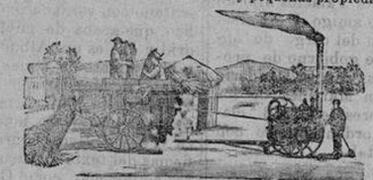
Rendimiento máximo con gasto reducido de combustible. Construcción muy sólida, de poco peso y fácil transporte, aun sobre terrenos muy quebrados. Locomóviles puestas en presión en doce minutos, mediante un nuevo aparato patentizado:
