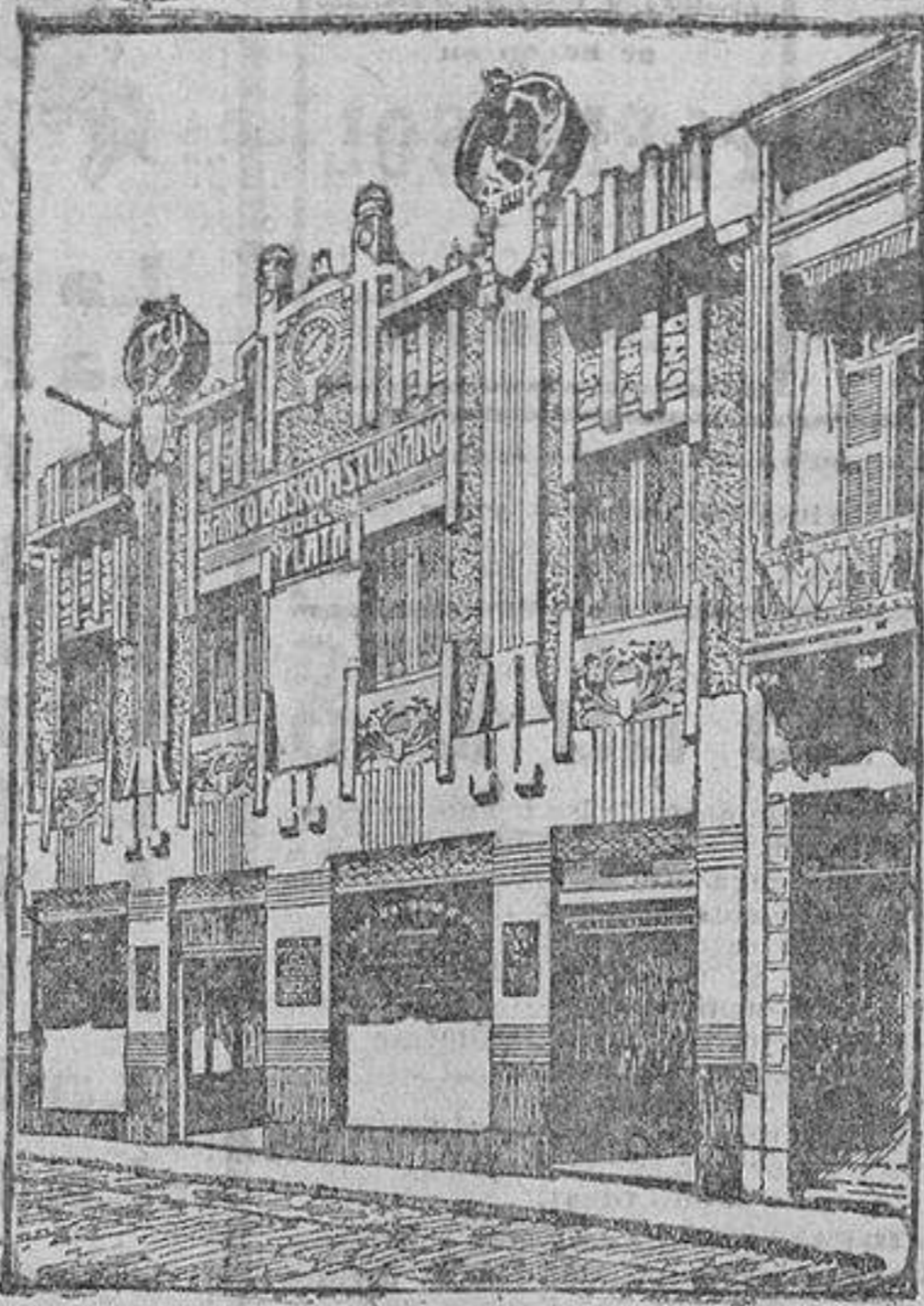
EDIFICIO DEL BANCO
