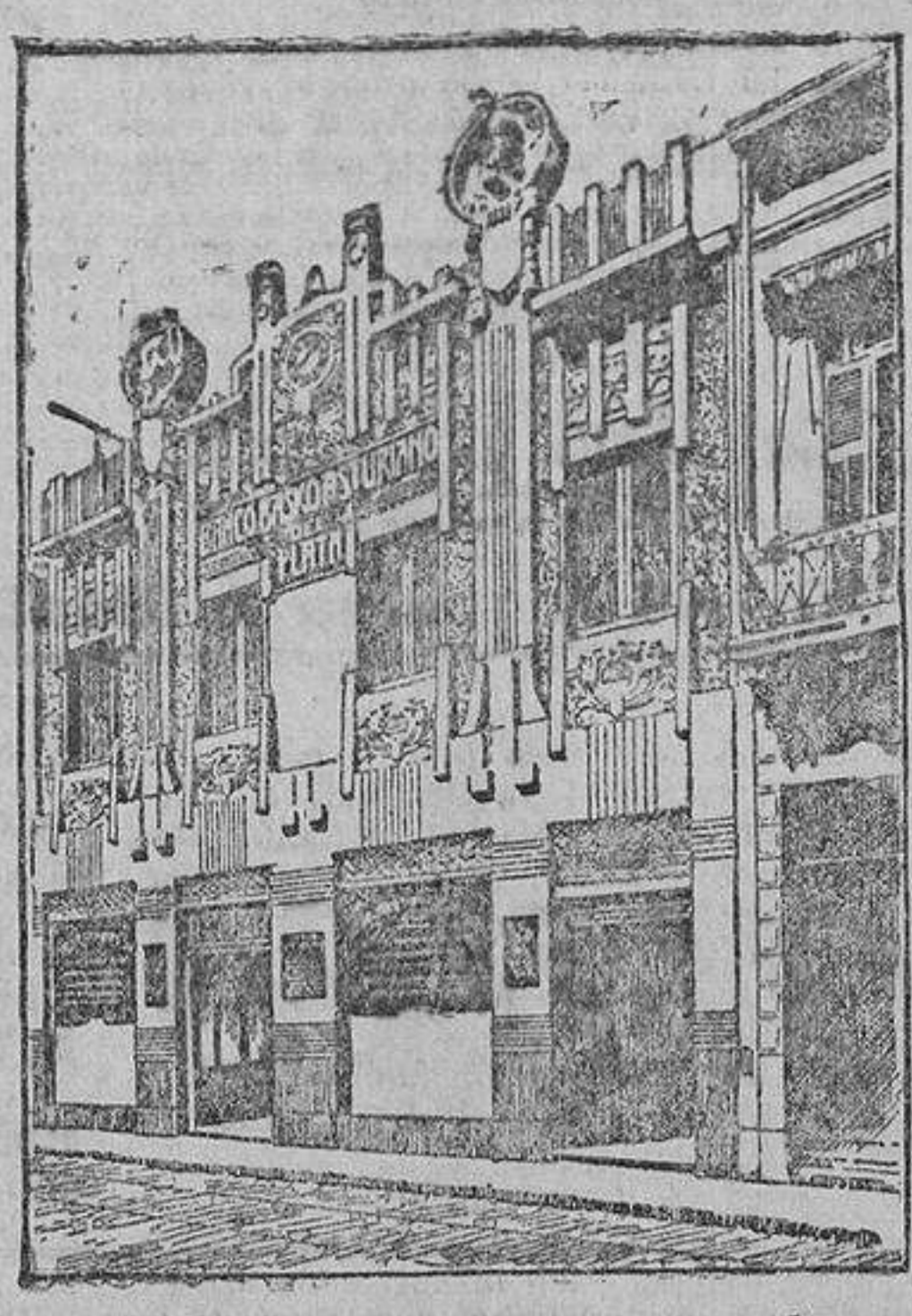
EDIFICIO DEL BANCO
