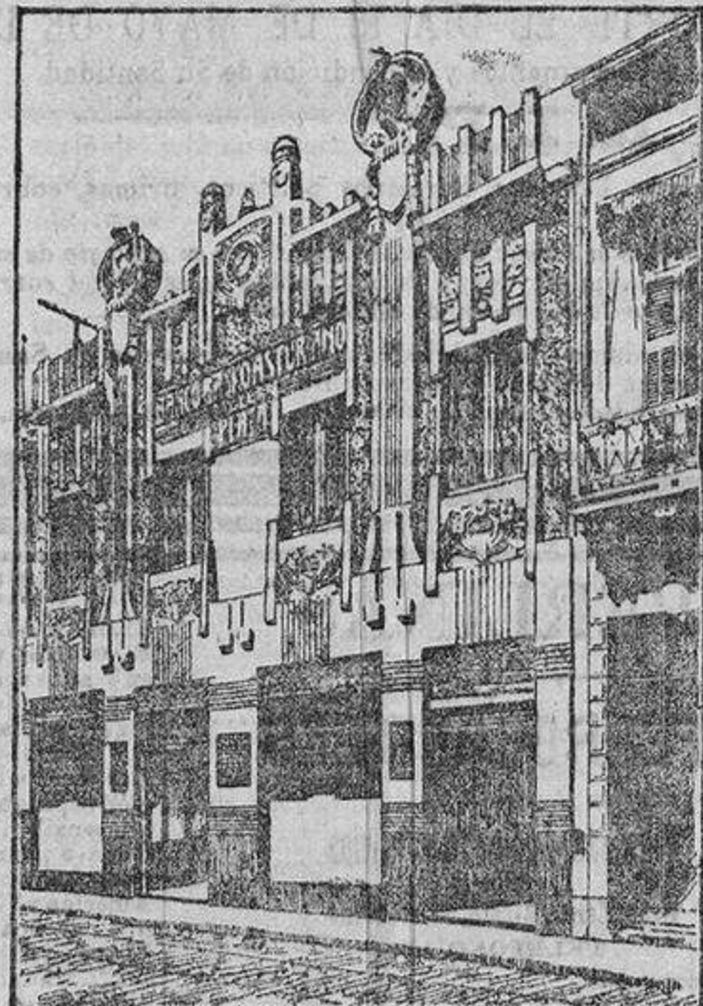
EDIFICIO DEL BANCO
