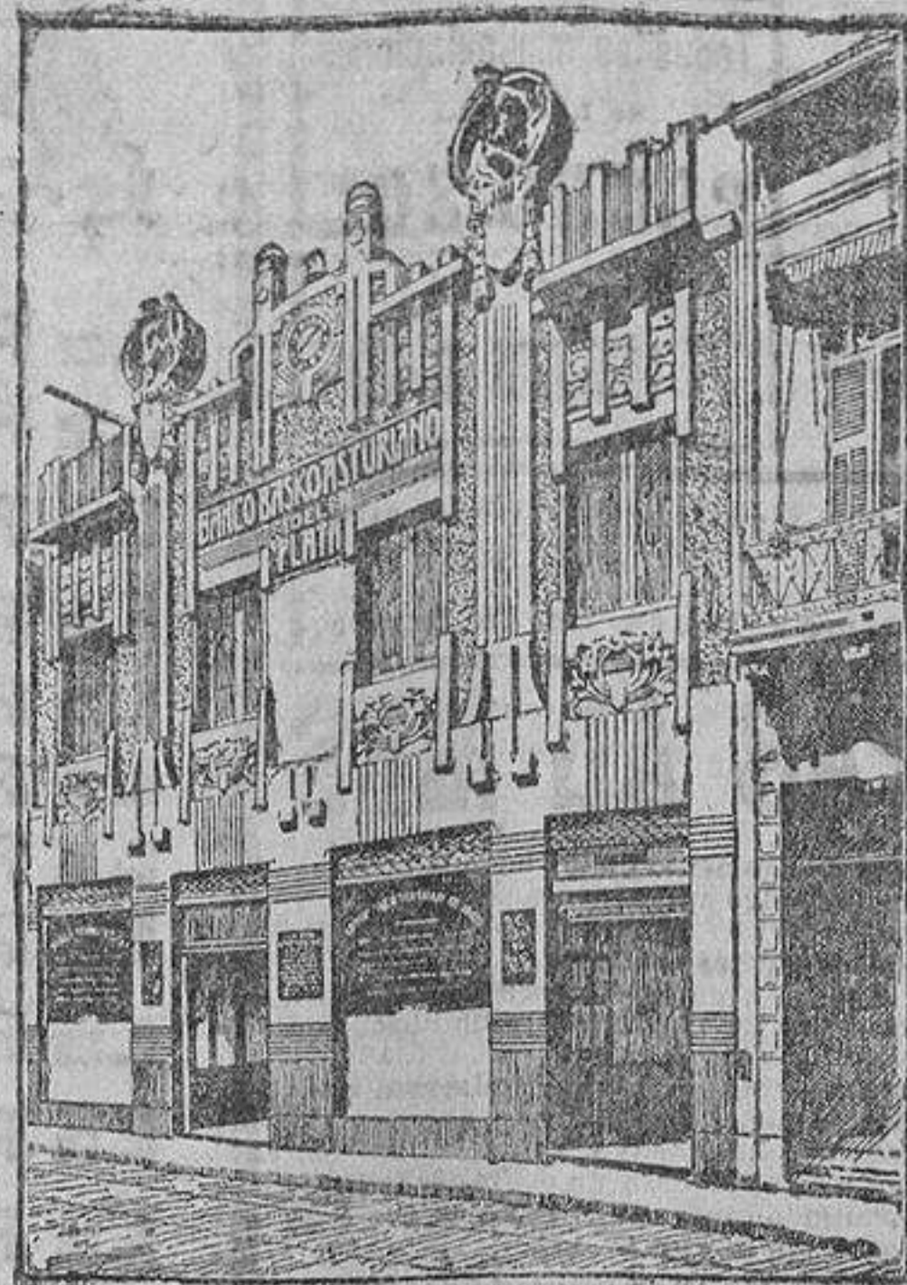
EDIFICIO DEL BANCO
