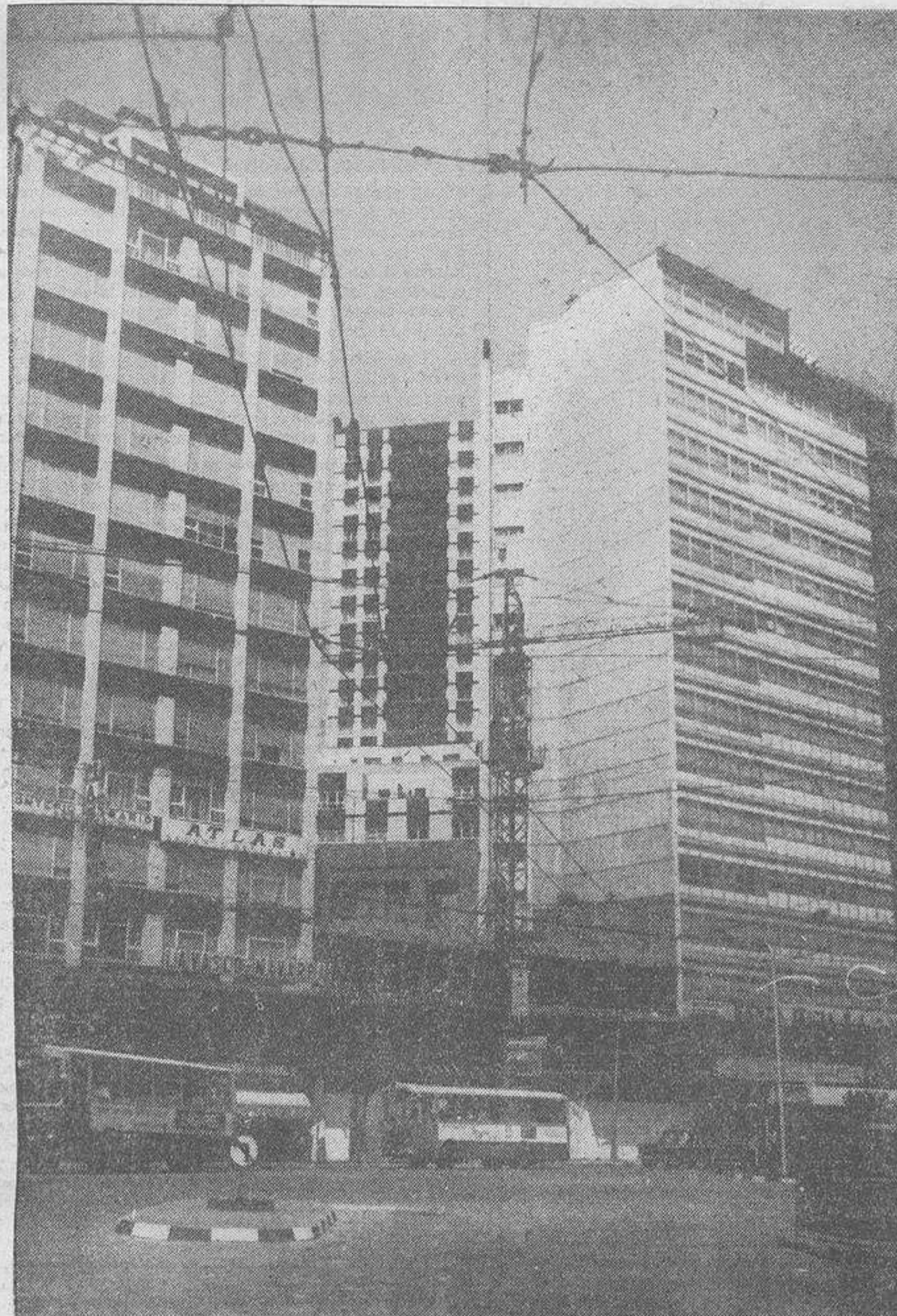
Con otras vías coruñesas, la Plaza de Pontevedra ha experimentado una gran transformación en su arquitectura. Al lado de viejos inmuebles de escasa altura se alzan hoy grandes edificaciones. En la foto de Quián, una nueva casa en avanzado estado de construcción
