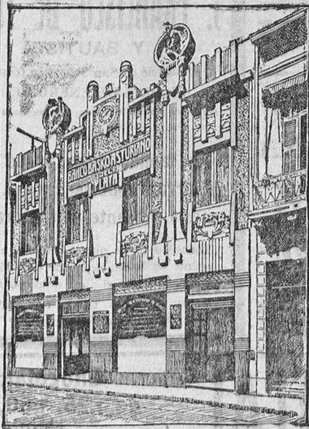
EDIFICIO DEL BANCO
