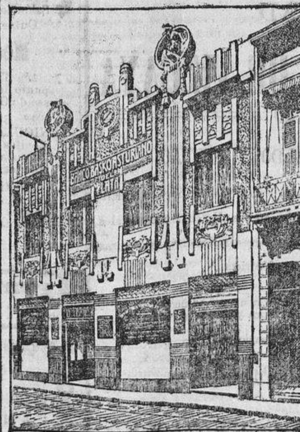
EDIFICIO DEL BANCO
