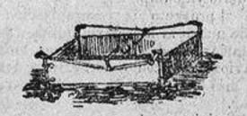
Consiste el sistema en colocar en los cuatro ángulos de un barco rectangular, otras tantas hélices horizontales movidas por un eje acodado que puede ser impuldo por dos hombres.
