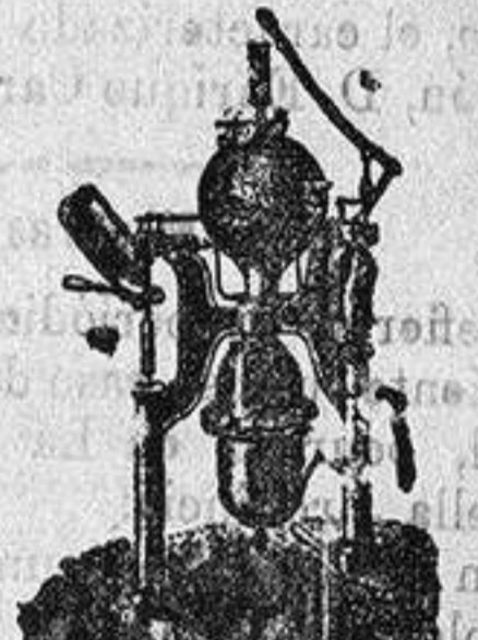
Aparatos para hacer gaseosas. Intermitente
