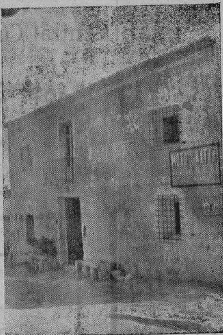
Fachada del edificio, casa de labor en donde vive Vicenta con sus padres.
