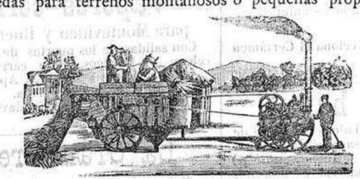
Rendimiento máximo con gasto reducido de combustible. Construccion muy sólida, de poco peso y fácil transporte, aun sobre terrenos muy quebrados. Locomóviles puestas en presion en doce minutos mediante un nuevo aparato patentizado.
