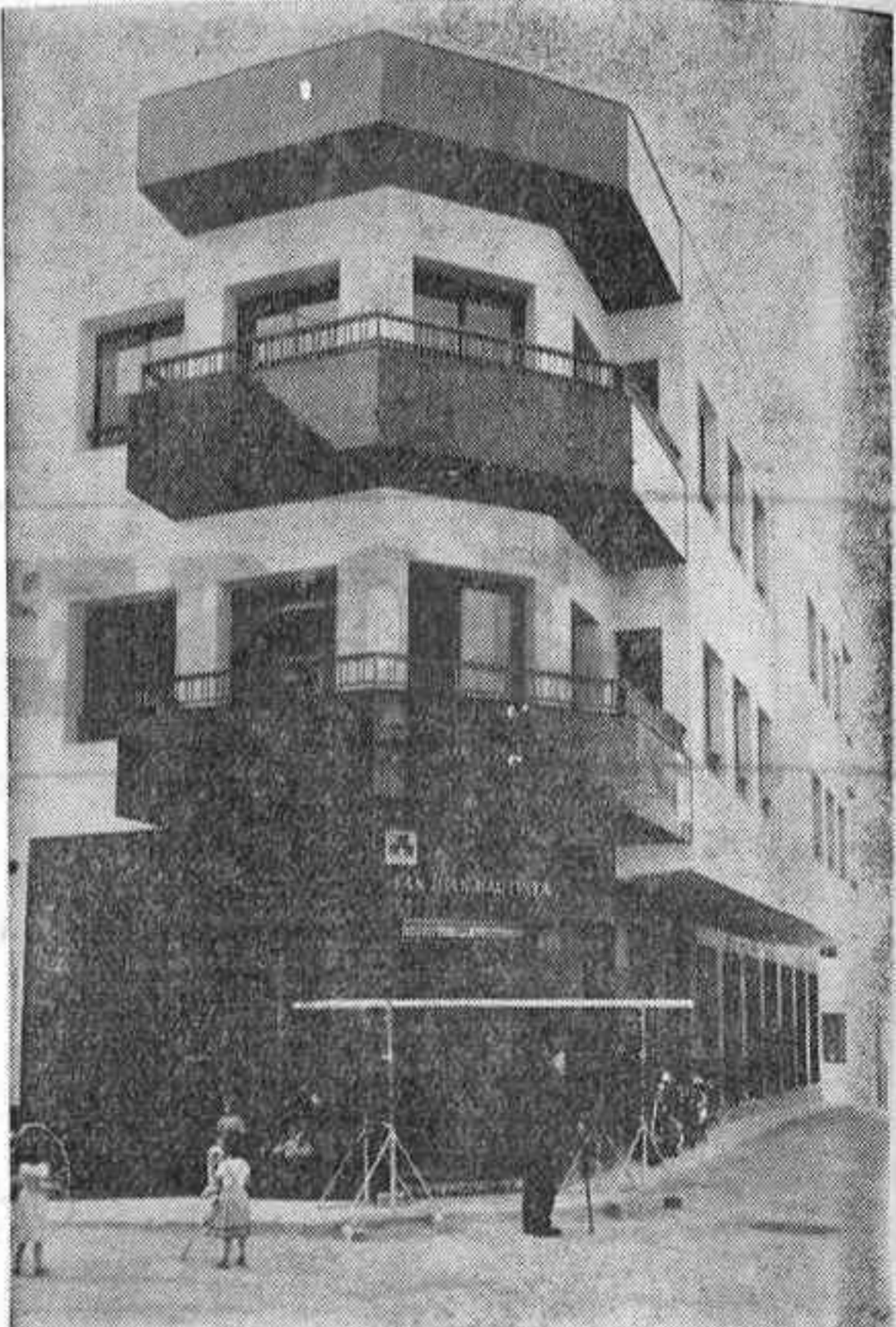
Las obras de construcción del nuevo edificio social, orgullo de todos los vecinos de San Juan de Moró, han impedido que coincidiera exactamente la celebración del cincuentenario con la fecha justa de este, pero eso no obsta para que, cuando en el próximo mes de agosto se lleven a cabo los actos que ahora están en fase de organización, los mismos tengan el máximo esplendor e incidencia popular. Hoy, al hablar del cincuentenario y de la trayectoria seguida por la Cooperativa de Crédito Caja Rural y Cooperativa Agrícola «San Juan Bautista», hay que recordar a los hombres que inicialmente empujaron el timón de esta empresa comunitaria: José Renau Rubio, primer presidente, y Camilo Valles Ruano, secretario. A estos sucedieron otros hombres que lucharon con toda ilusión, hasta conseguir lo que hoy son estas entidades. San Juan de Moró ya no depende, como antes, de la actividad agrícola. Hoy, sus habitantes se dedican fundamentalmente a la industria. Se ha producido por lo tanto una gran transformación de las condiciones sociales de la población, a las que la Cooperativa Agrícola y la Caja Rural se han ido adaptando, para estar siempre en primera línea de servicio, al frente de la más nobles iniciativas de progreso. El proceso culmina con la construcción del magnífico edificio que suplirá a las viejas oficinas. Las obras se han demorado un poco, por los imponderables que suelen afectar a este tipo de empresas. Pero prácticamente concluirán en cuestión de semanas, porque se trabaja ya en los últimos detalles, y San Juan de Moró podrá disponer no solo de una instalación que estará a la altura de los mejores entre las de su genero, sino, lo que quizá sea más importante, con un centro en el que se podrán llevar a cabo numerosas actividades culturales, porque el inmueble no va a ser cerrado, sino centro abierto a las mejores inquietudes de los socios y pueblos en general. (Foto: HEREDIO)
