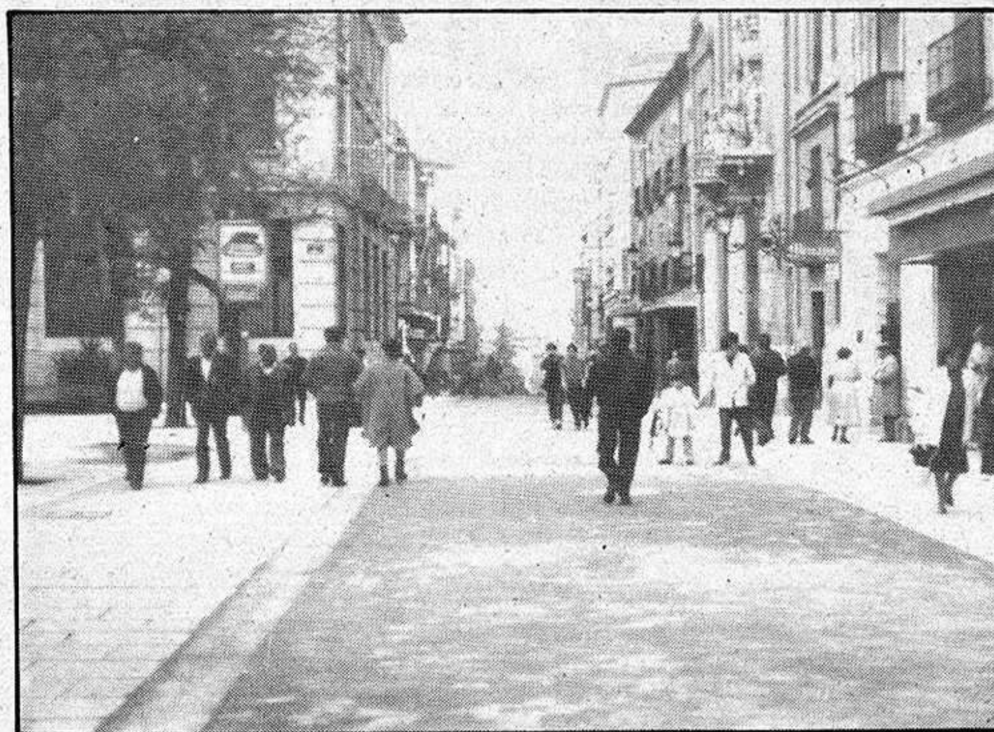
El PCE critica la peatonalización de la calle Mayor, que será inaugurada el próximo día 30 de mayo
