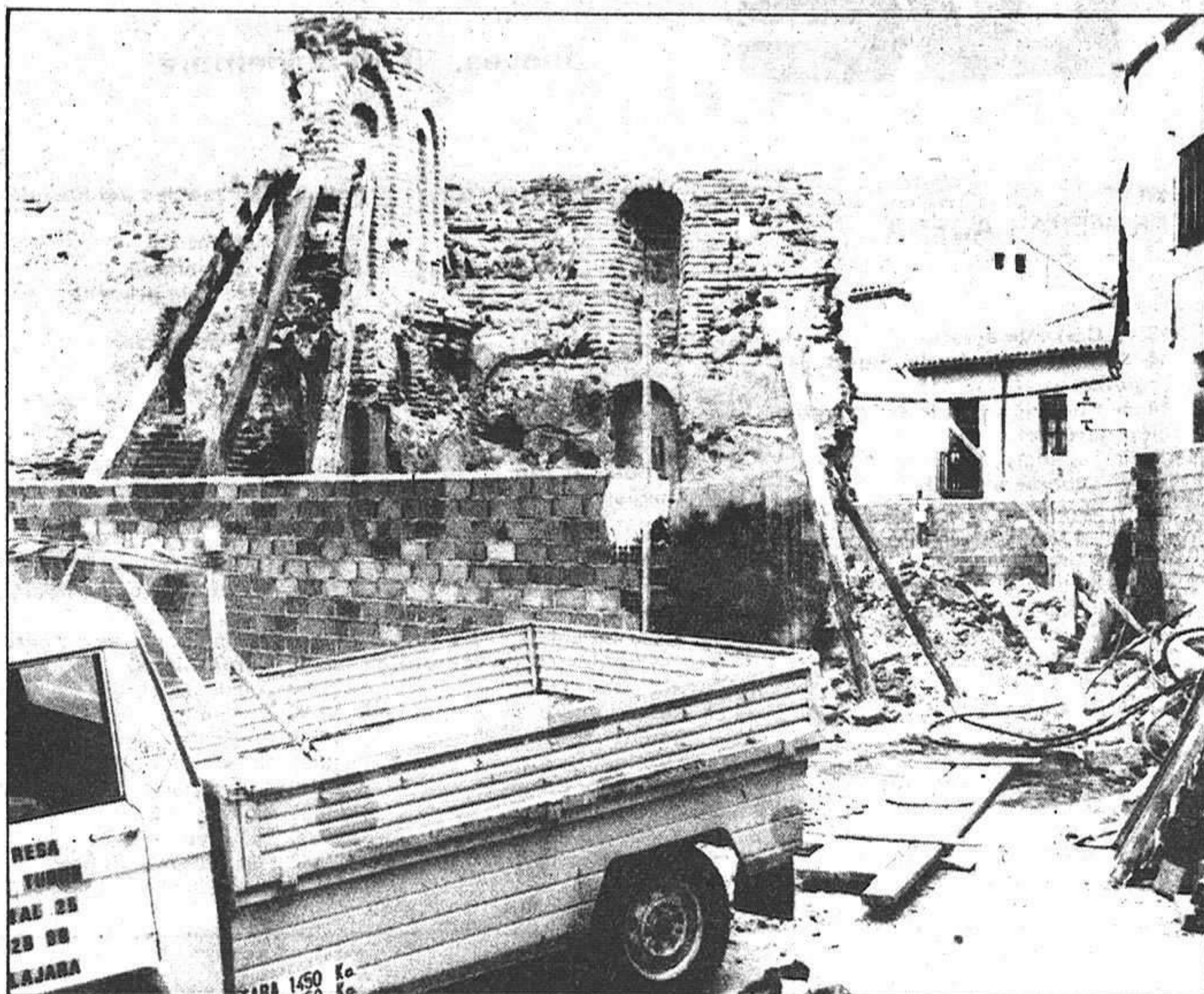
La instantánea muestra el aspecto del monumento pocos días después de comenzadas las obras.
