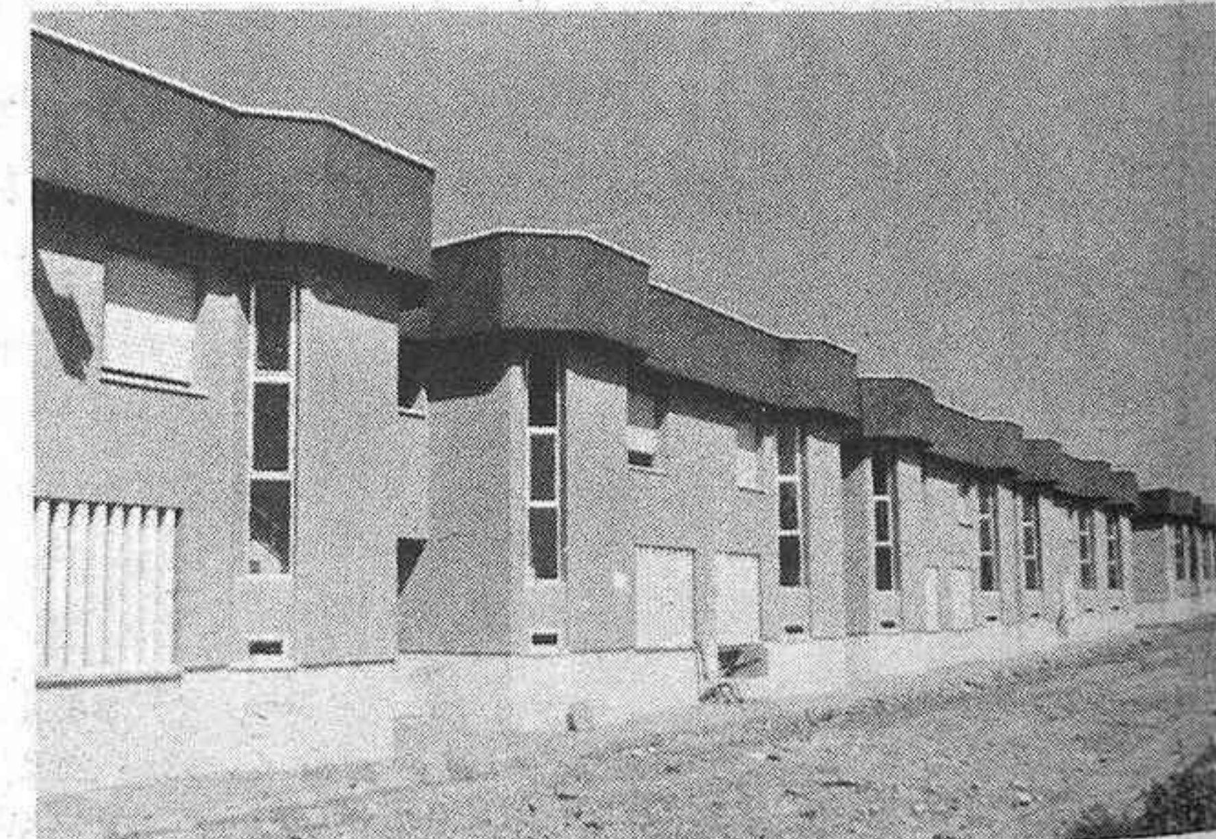
Detalle de la cárcel que se construye en la carretera de Alcora
