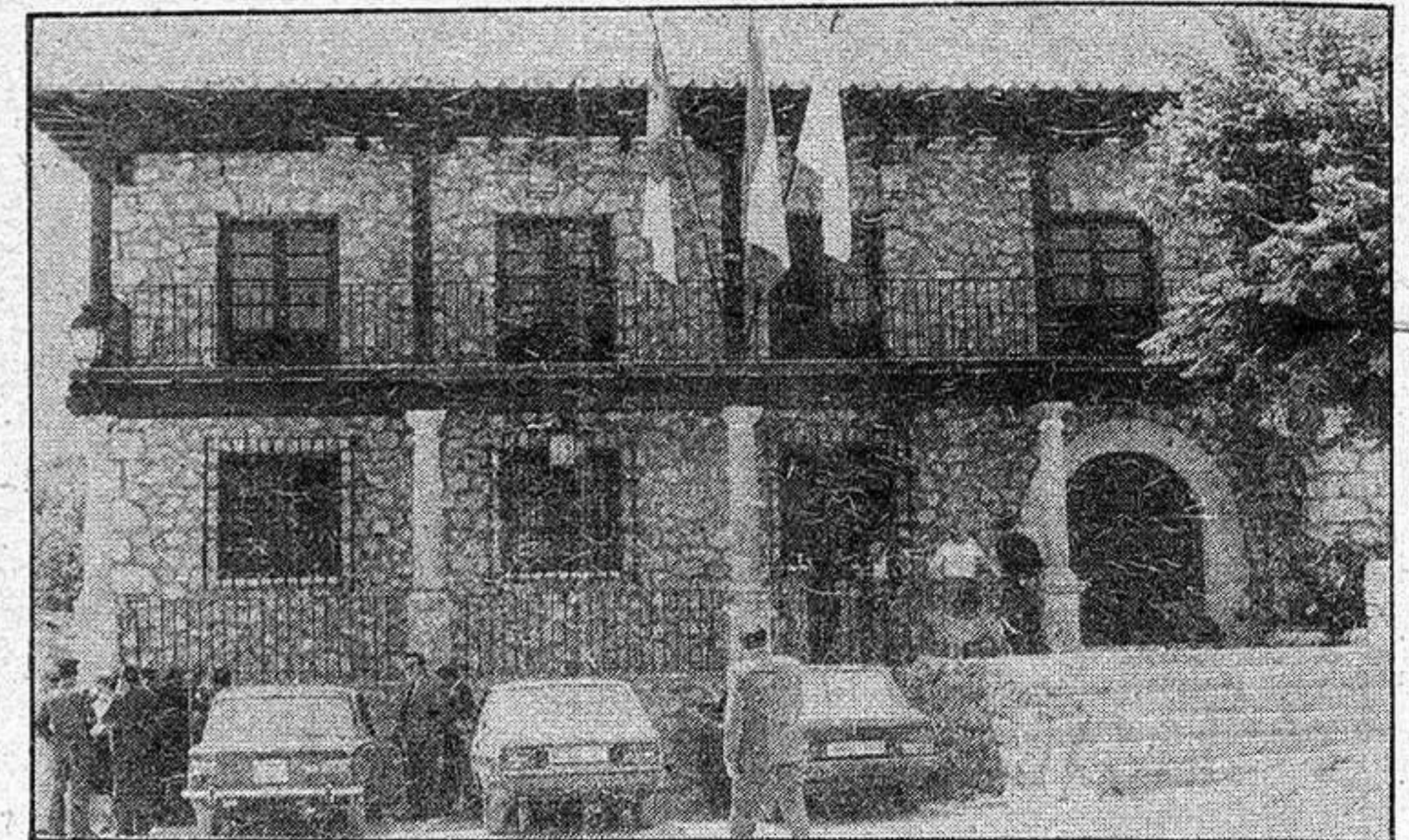
La plaza de Alocén ha quedado totalmente pavimentada. En la fotografía, el día que fue inaugurado el Ayuntamiento.
