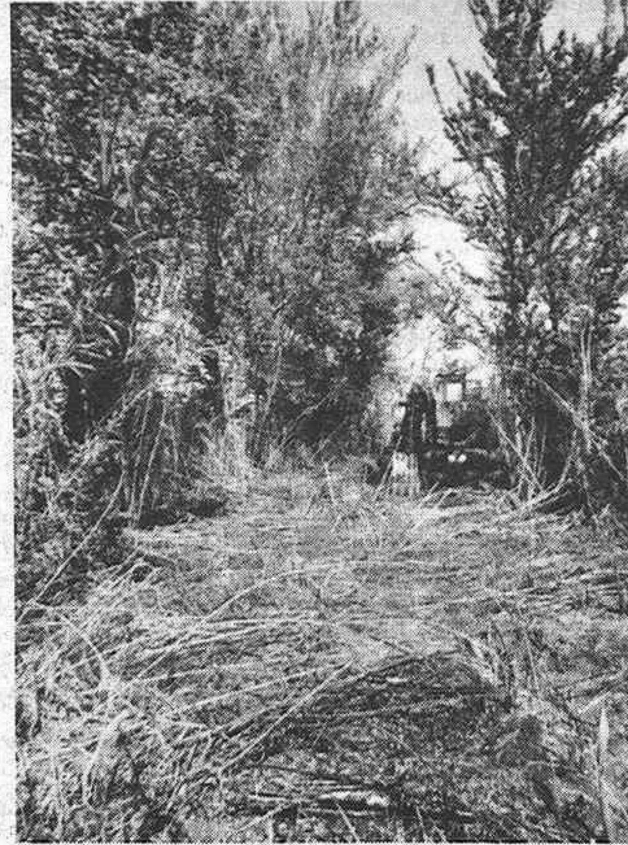
Iniciación de los trabajos de construcción del vial de acceso del margen opuesto a la ermita (23.4.83). (F. Broch-Lino).
