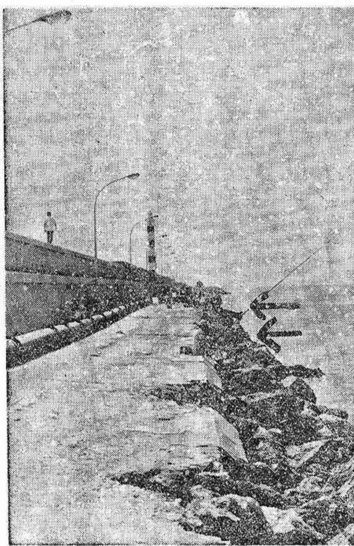
Las flechas indican el lugar aproximado en que se situará el nuevo atraque de fluidos peligrosos
