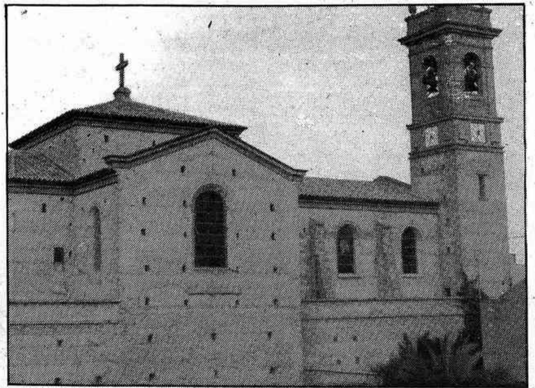
Toda la obra costó seis millones de pesetas
