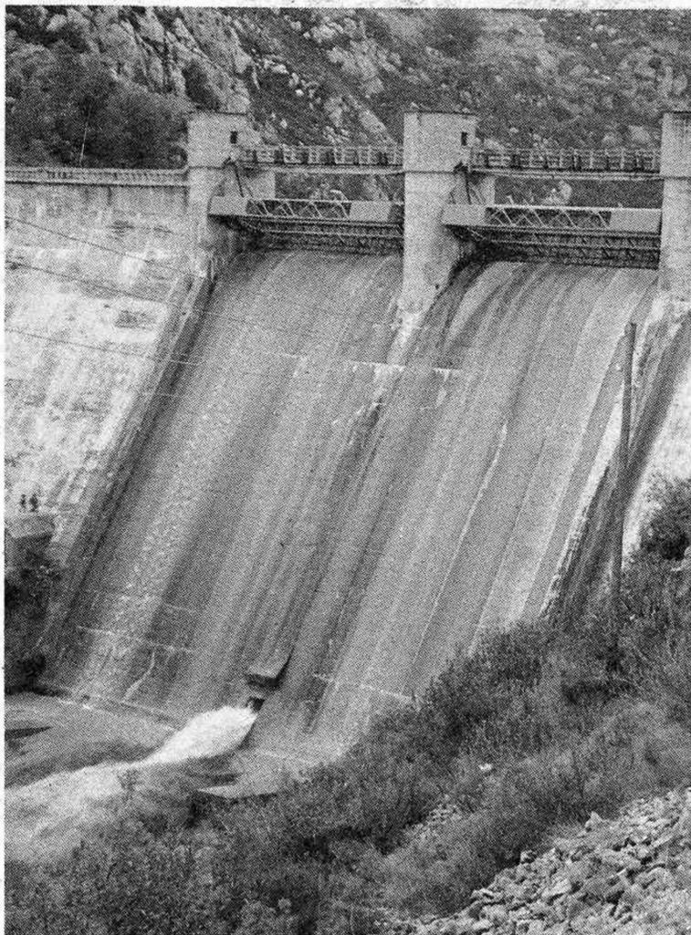
Apertura del desagüe de fondo, en el vaciado del embalse el 28-11-83, por atascamiento de la toma de riego inferior.
