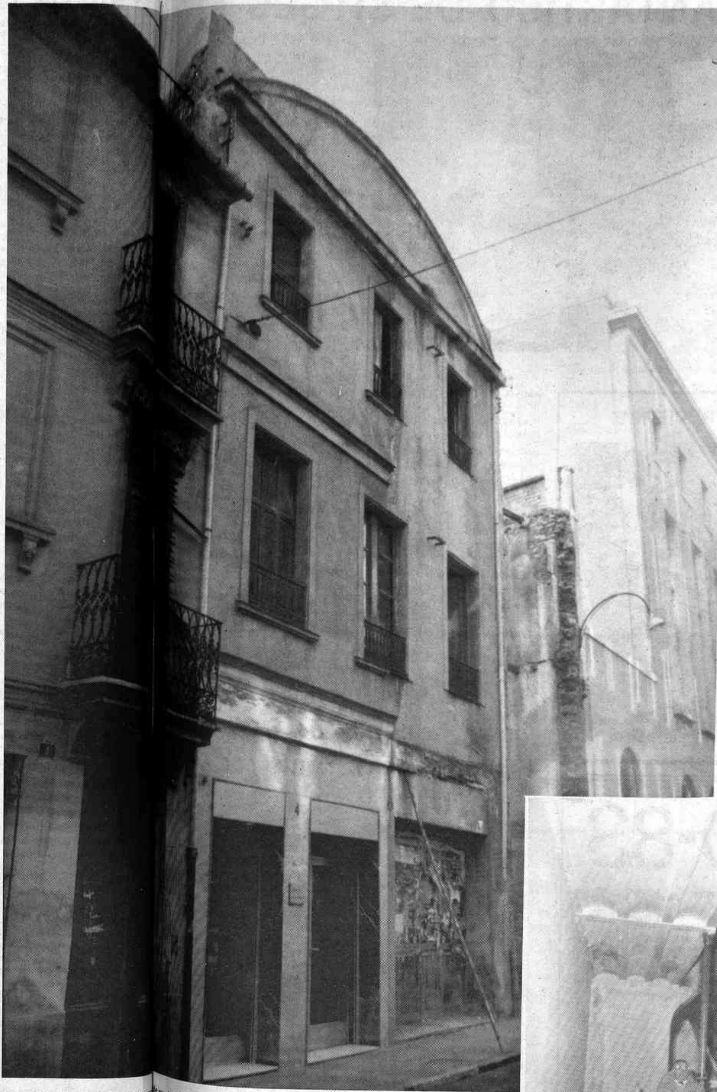
La fachada principal del «Teatro Nuevo» que la «piqueta bancaria» entrara a «saco». Se aprecia en la misma las dos mitades en las que fue partido el teatro.
