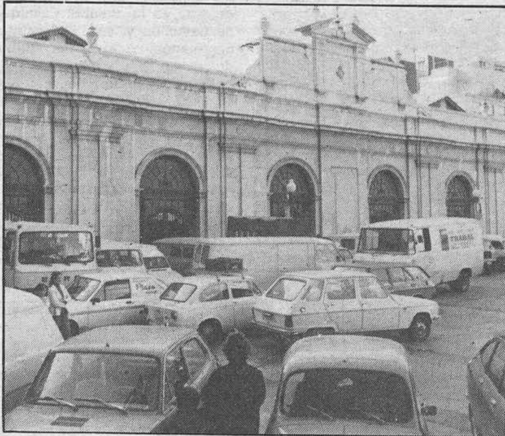
Los coches a causa de las obras no encuentran aparcamientos
