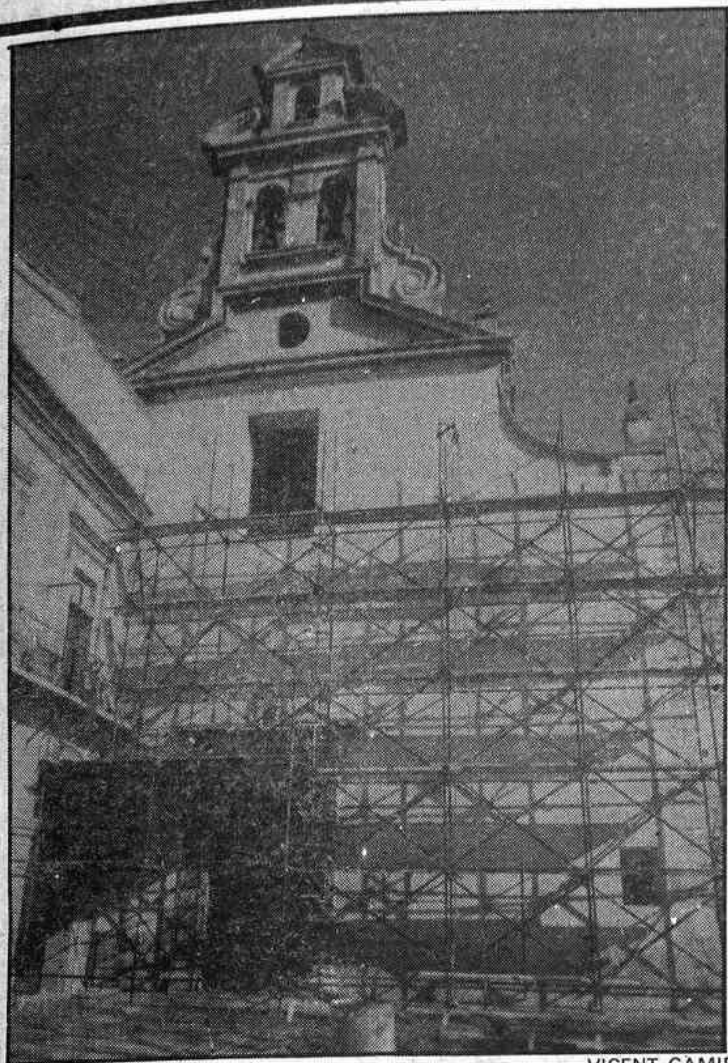
Estas obras consolidarán el edificio de Lledó VICENT GAMIR
