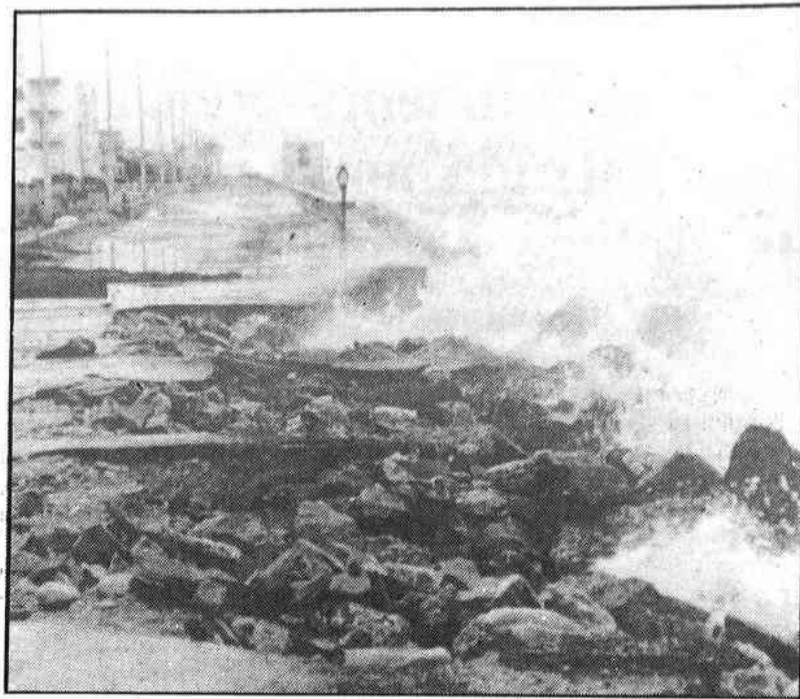
Estado de las edificaciones tras los temporales
