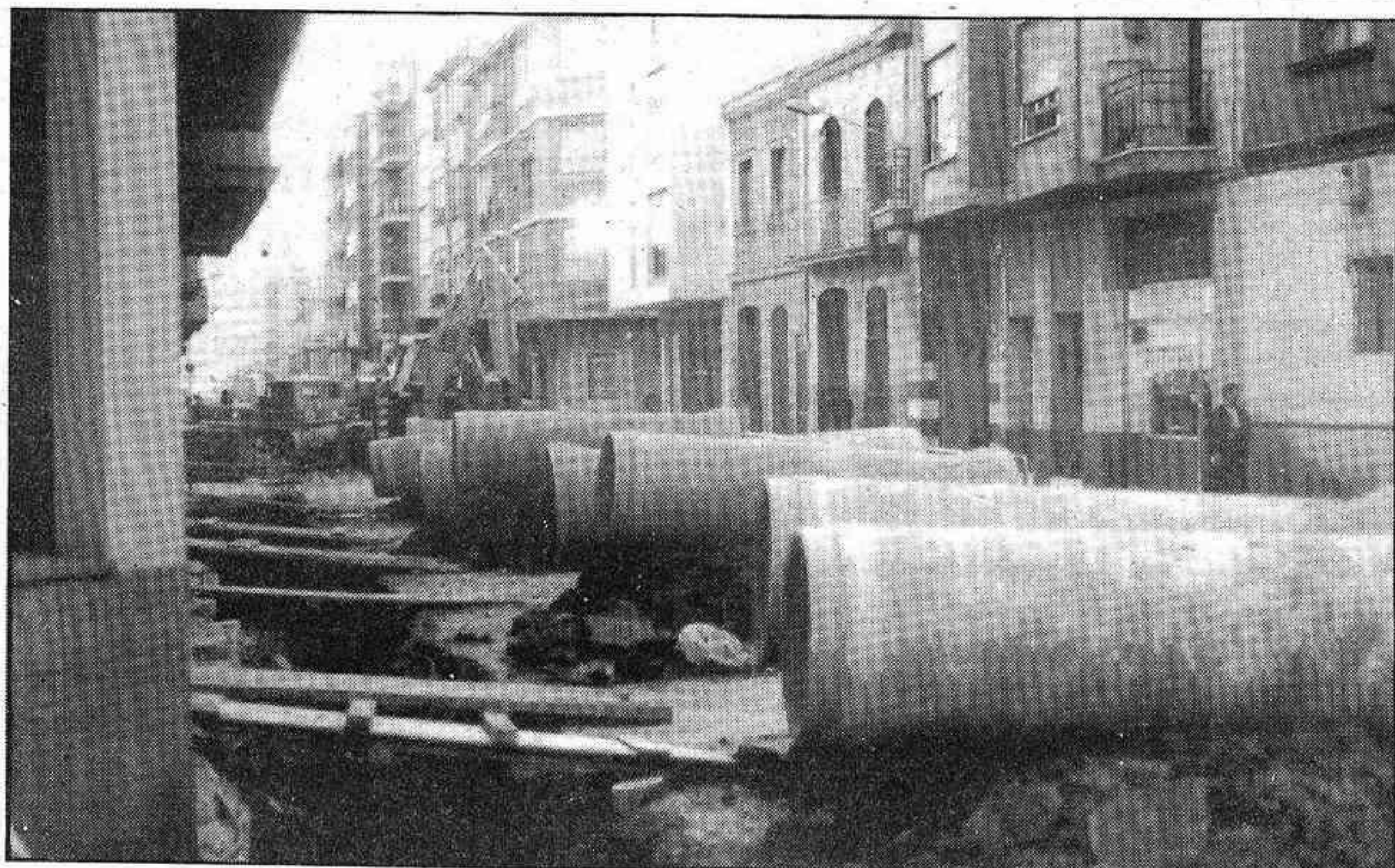
Las obras avanzan a buen ritmo
