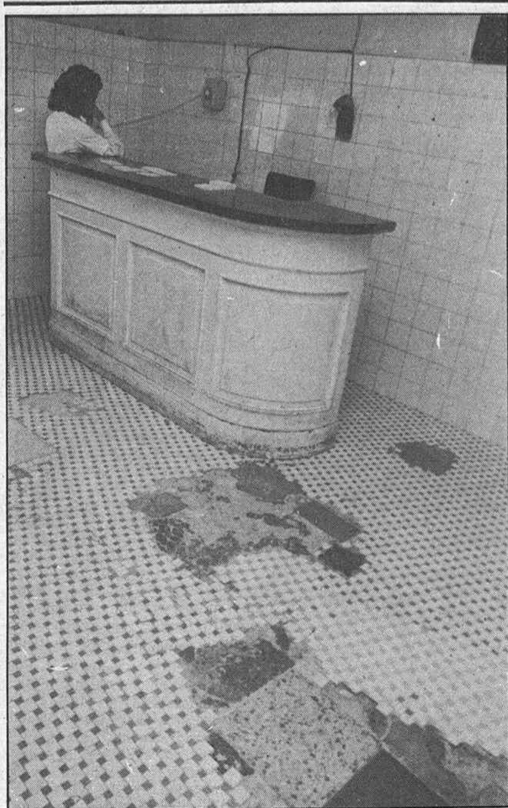
Todo el edificio va a ser remodelado / V. GAMIR
