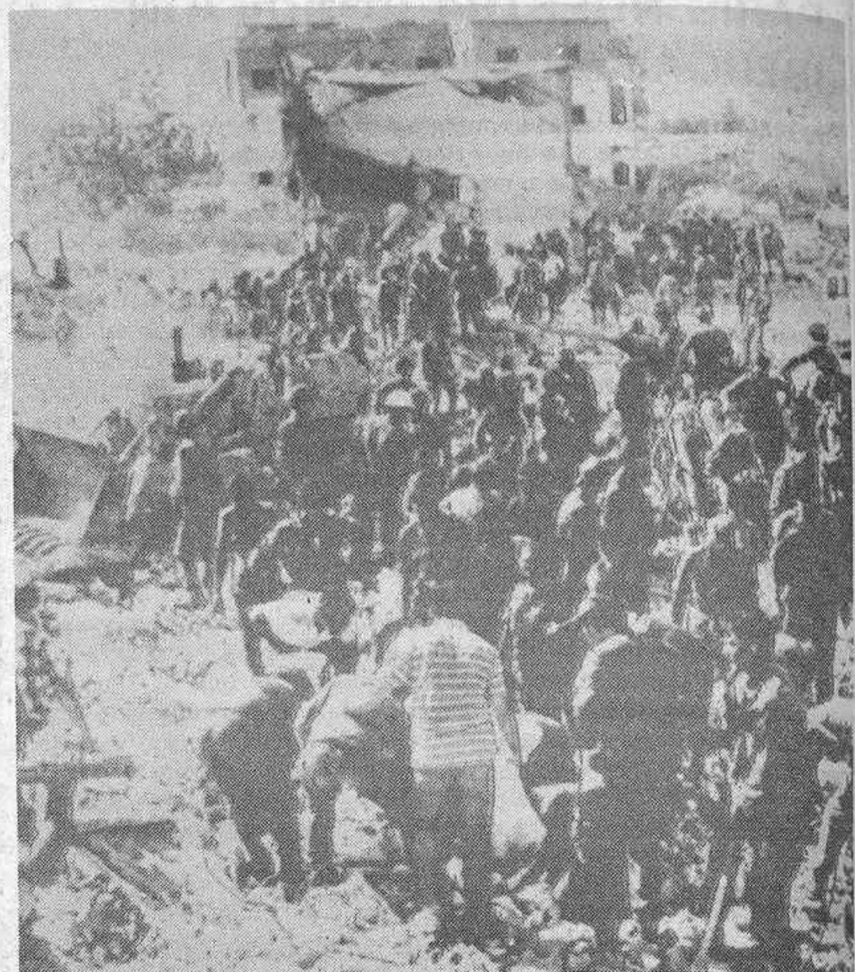
Tiro. El vehículo cargado de explosivos que colisionó contra el cuartel general del ejército israelí, dejó en ruinas parte del edificio.
