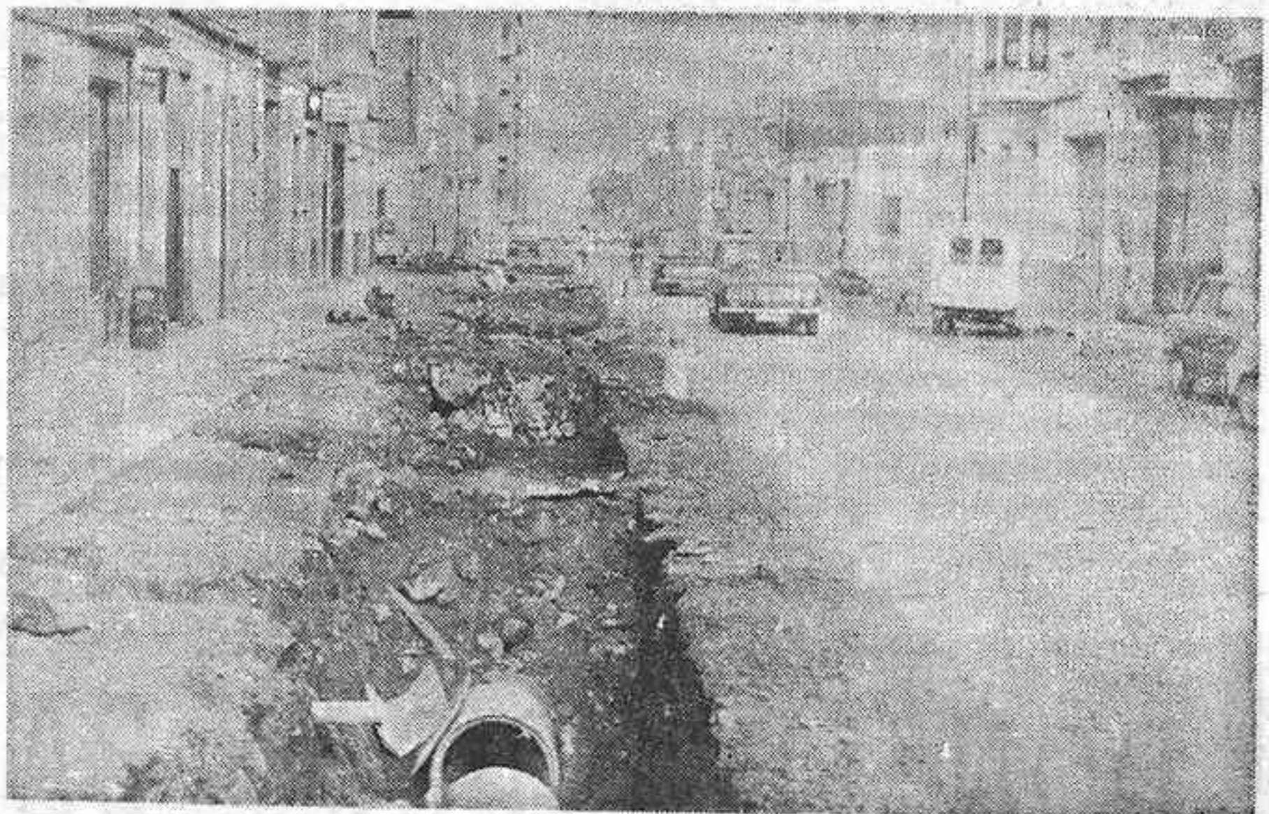
Estado de las obras en un sector de la Avenida de José Antonio
