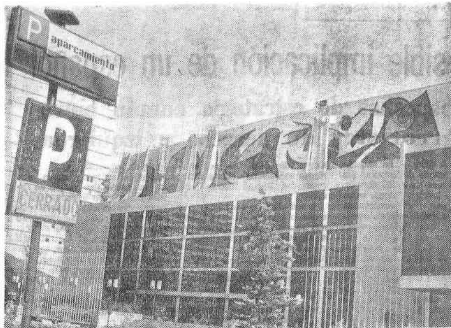
MADRID. — Están a punto de finalizar las obras para la colocación del mural de Joan Miró, que está situado en la fachada del Palacio de Congresos y Exposiciones de Madrid. —(Foto EFE)
