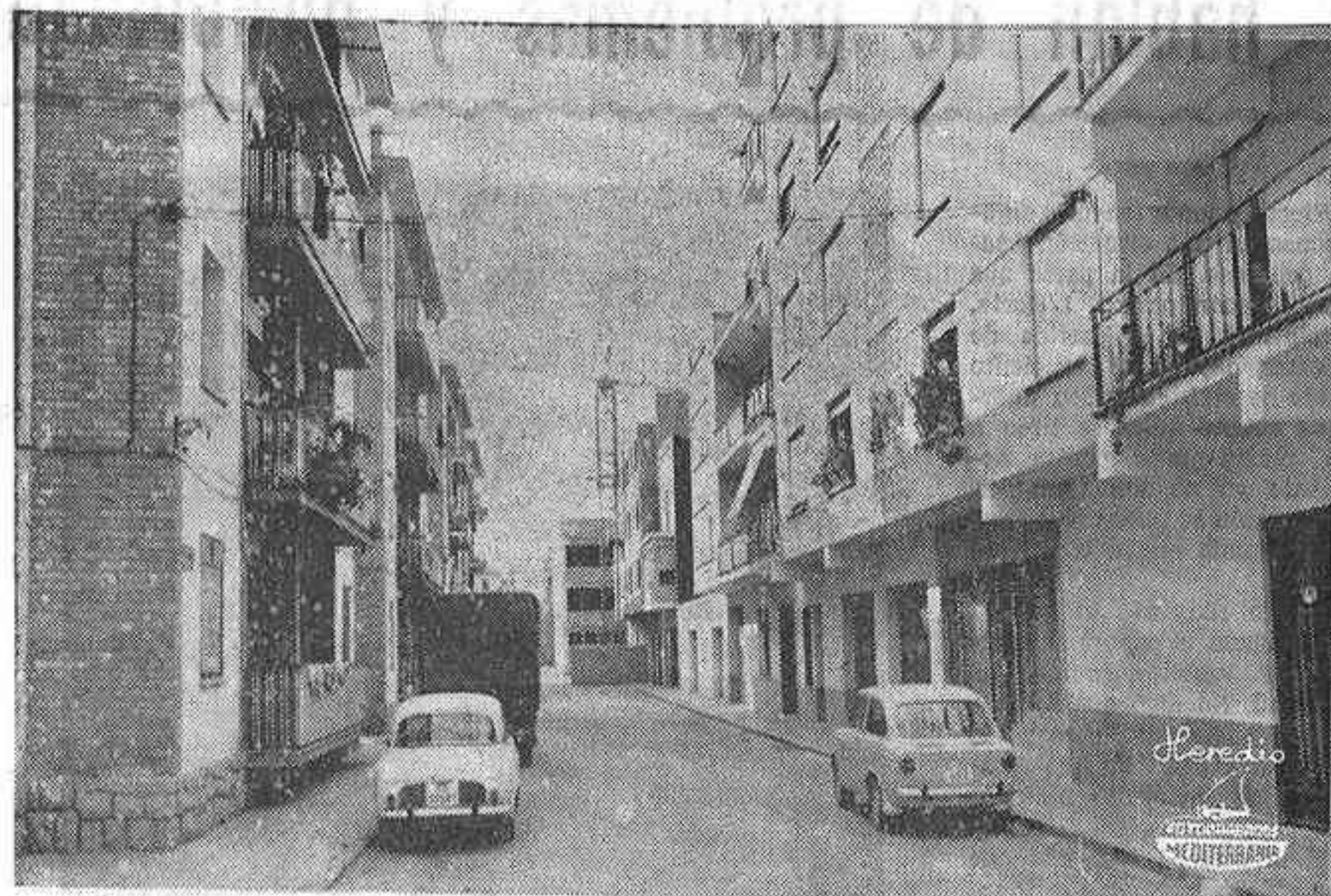
Una de las zonas en la que más se observa la actividad constructora es la comprendida entre la carretera nacional 340 y la travesía de San Pascual.
