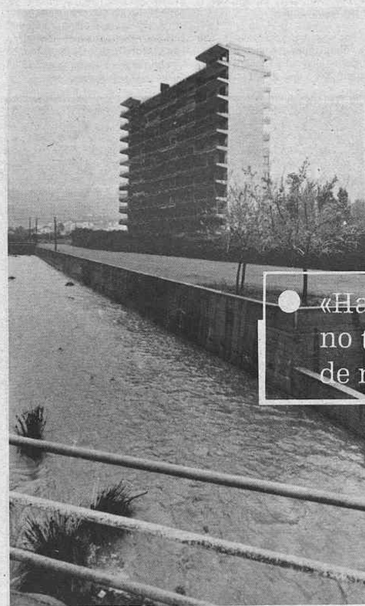
Otro aspecto del barranco de Farcha, habitualmente seco, el domingo con agua
