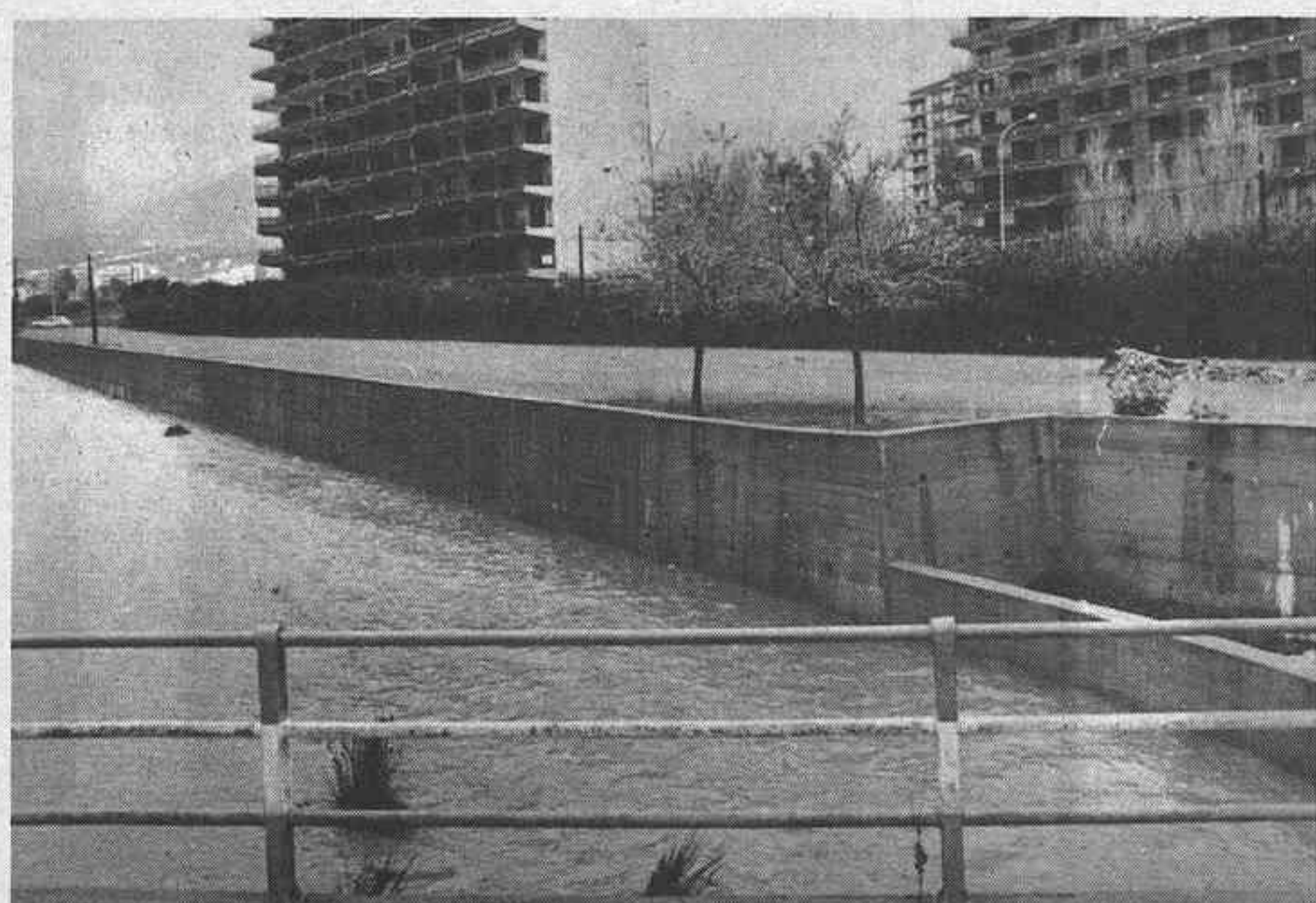
«El barranco de Farcha en el cruce con la carretera de la costa»
